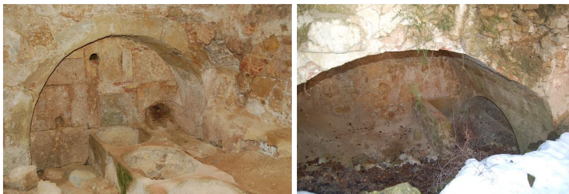
Fig. 16 y 17, Izq. Tres de las cinco pilas que todavía conserva el molino Bonic. Dcha. Pudridero cobijado bajo una bóveda de cañón.
