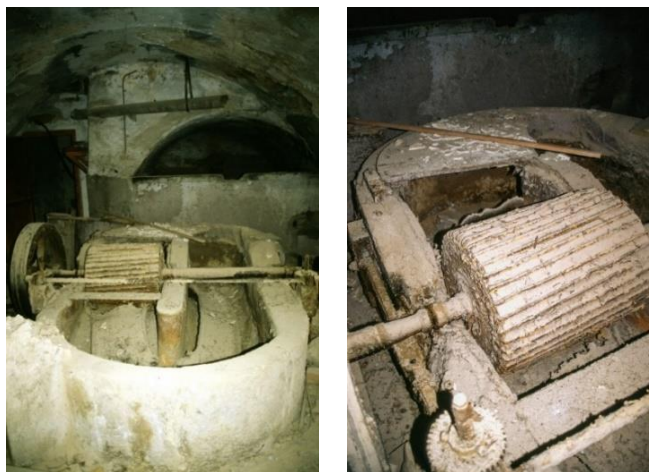
Fig. 44 y 45, Fotos de una pila holandesa empleada en la Fábrica Font del Pas. Actualmente se encuentra desmontada y almacenada en las dependencias del hotel erigido en las instalaciones del molino. Extraídas de: Archivo Hotel Font del Pas (AHFP)
