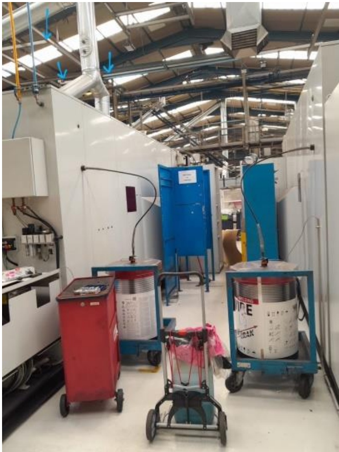
Fig. 12 Foto señalizada de las vigas donde va el anclaje estructural.
