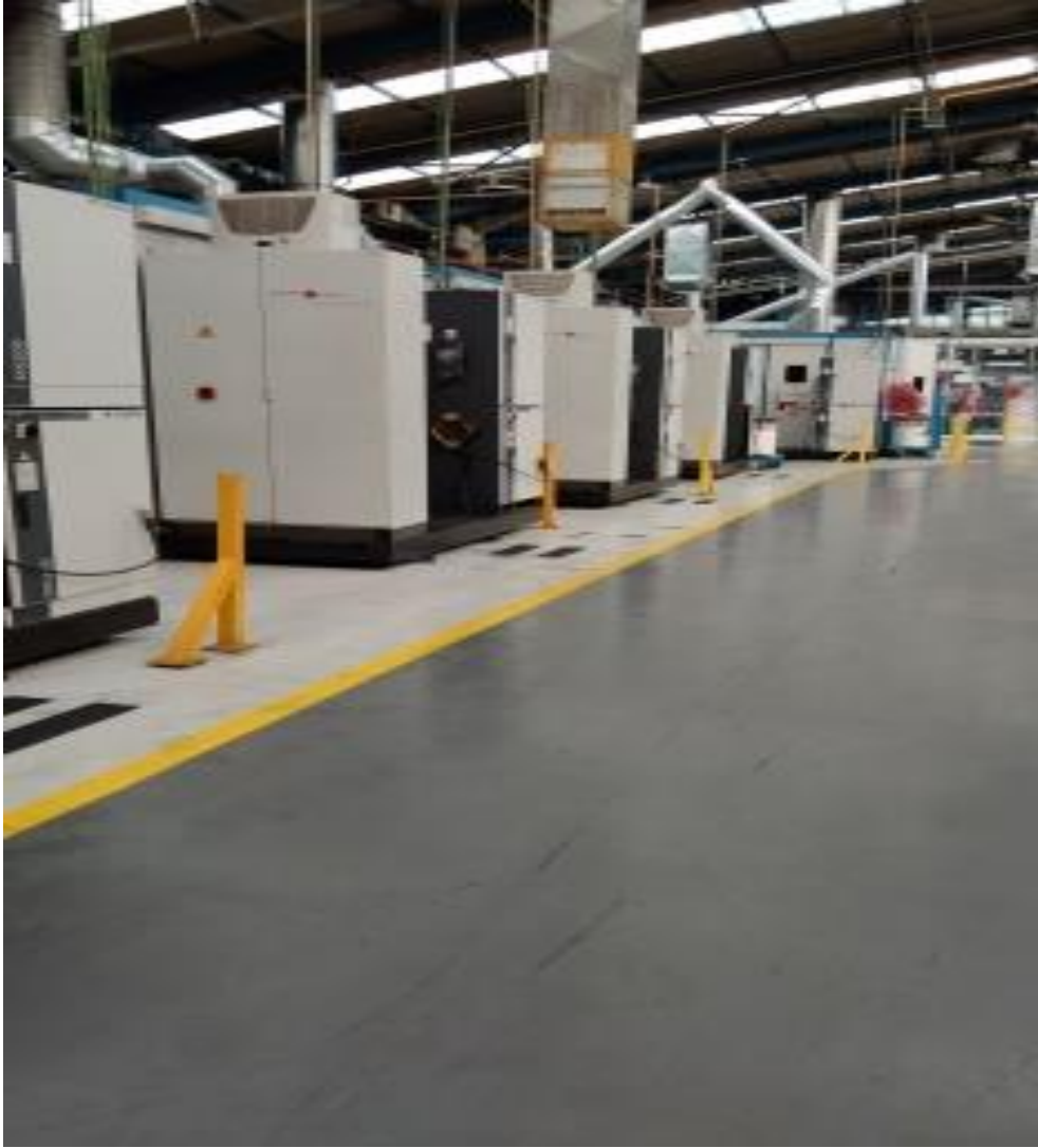
Fig. 10. Foto área de acceso de la PEMP a las cubiertas de los módulos
