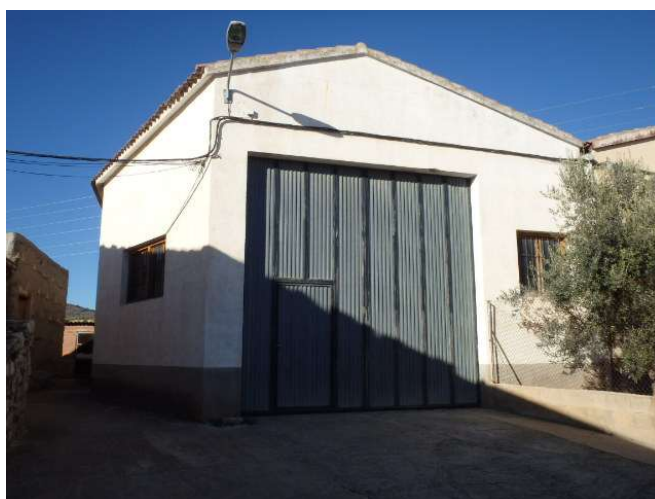
Figura 10. Imagen de la fachada de la nave (Sede Catastro, 2025).
