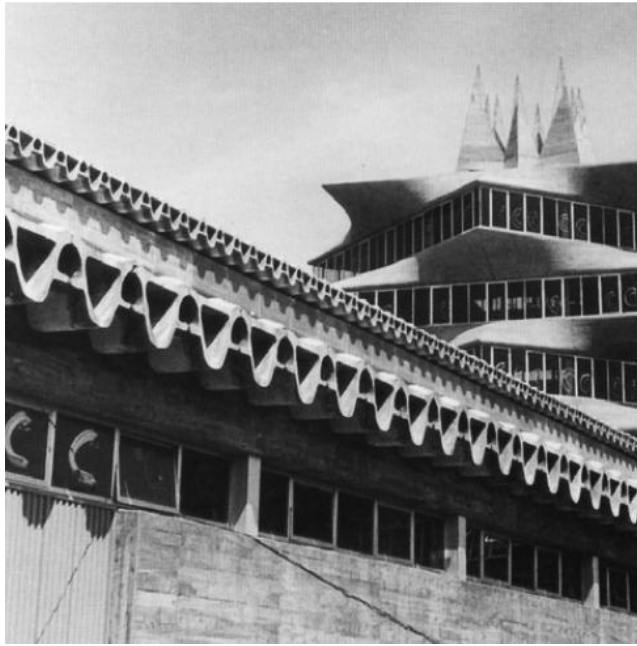
Imagen 30. Centro de estudios hidrográficos, Madrid. 1960-63. Cubierta de vigas de hormigón.
