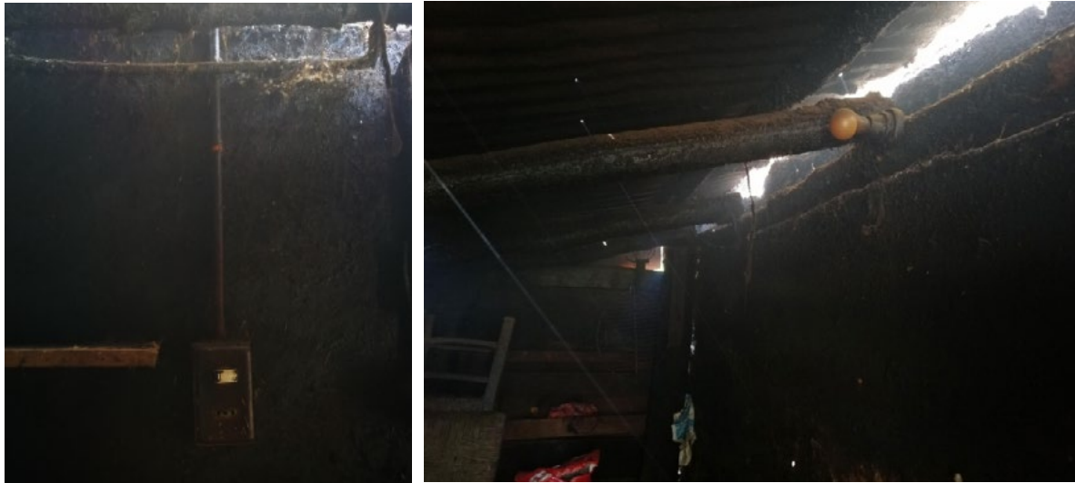
Figura 190 Muros ennegrecidos de una concina de humo en Rabones
