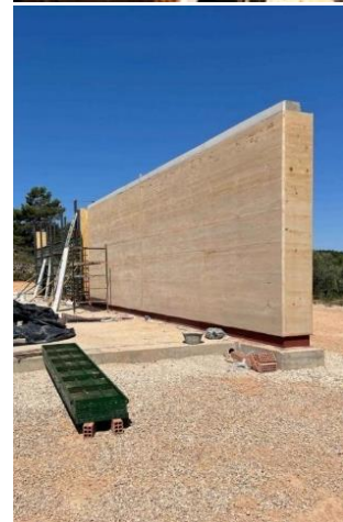
Fig. 21: Ejecución del muro de tapia – Zest architecture
