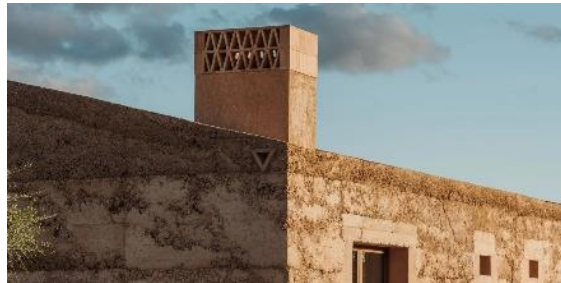
Fig. 66: En la esquina de la fachada, abertura de evacuación del conducto de cubierta – Munarq architects (Imagen adaptada)
