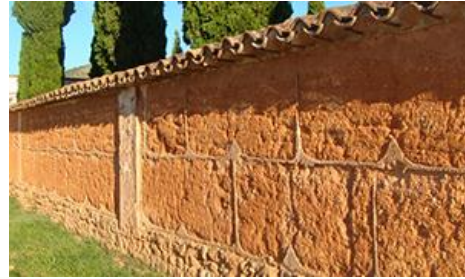
Fig. 10: Tapia con brecas en el cementerio de Torrebaja – Mileto, C. y Vegas, F. (2005)
