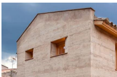
Fig. 71: Remate superior del muro de tapia – D'Arquer, X. (Imagen adaptada)
