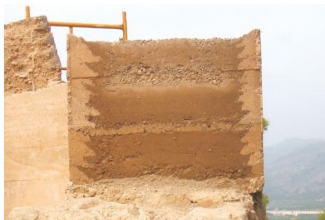
Fig. 6: Sección de muro de tapia calicostrada. La tapia en España. Técnicas actuales y ejemplos – Hidalgo, P. y Font, F. (2011)
