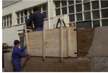
Fig. 12: Montaje del encofrado de un módulo – Cutillas, J. L. (2003)
