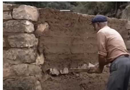
Fig. 14: Extracción de los travesaños tras el desencofrado de un módulo. Tapia con rafas y verdugadas de piedra – Monesma, E. (1993)
