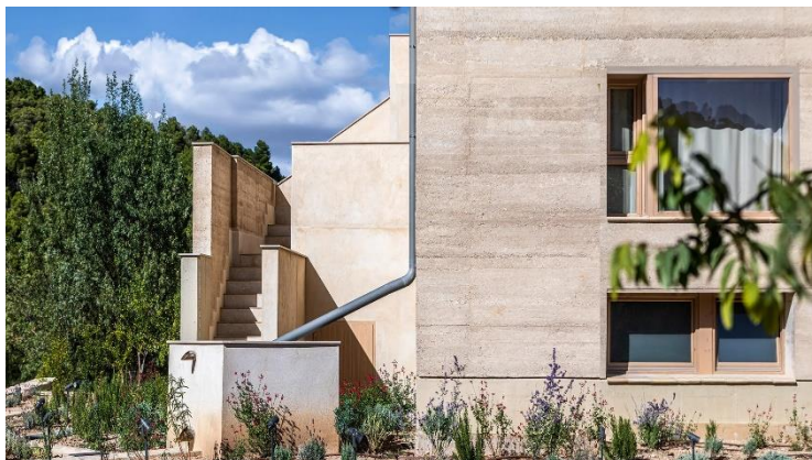
Fig. 73: Vista del arranque de las tapias, fachada norte – Edra Cultura y Natura
