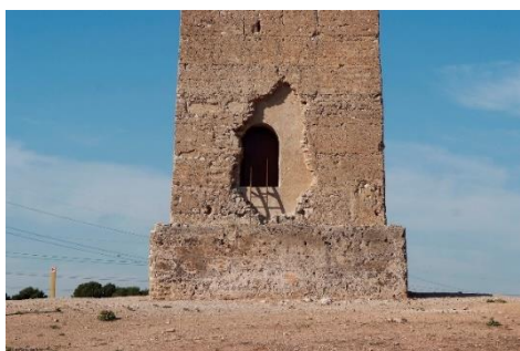
Fig. 2: Torre Bofilla (Valencia) levantada con tapia en su parte superior - Mileto, C. y Vegas, F. (2009)
