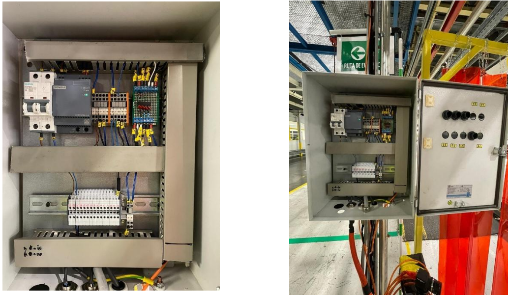
Figura 4. 64: Cuadro eléctrico de la estación de visión artificial
