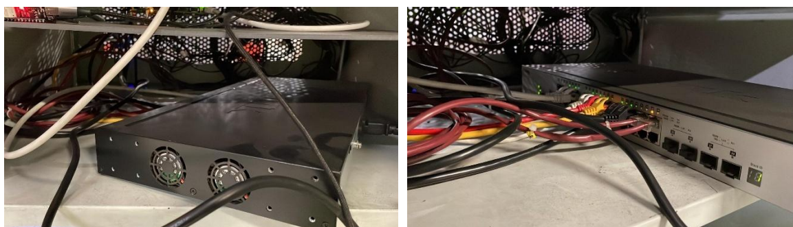
Figura 4. 25: Switch D-Link DGS-1024D 24 puertos en la estación
