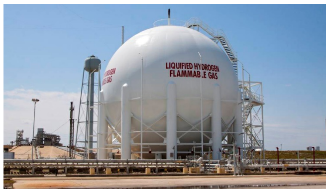
Ilustración 16 Tanque de almacenamiento de LH2 de forma esférica (Pérez, 2022)
