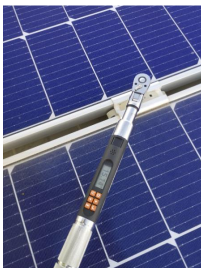
Ilustración 14 Par de apriete de las grapas (Enerland)
