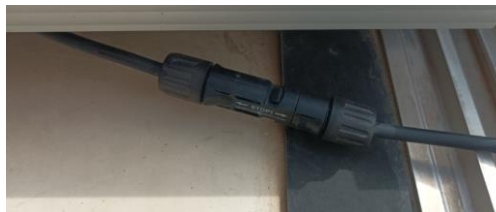
Ilustración 8 Conector MC4 (Enerland)
