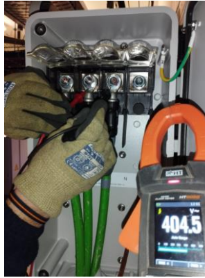
Ilustración 10 Medición de la tensión de fase (Enerland)
