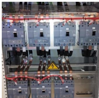
Ilustración 20 Cuadro de corriente alterna (Enerland)
