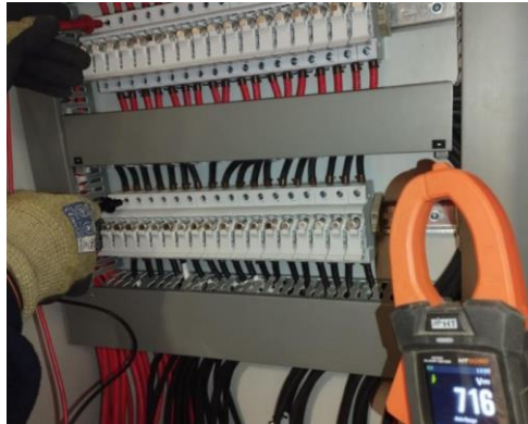
Ilustración 15 Medición del cuadro de corriente continua (Enerland)
