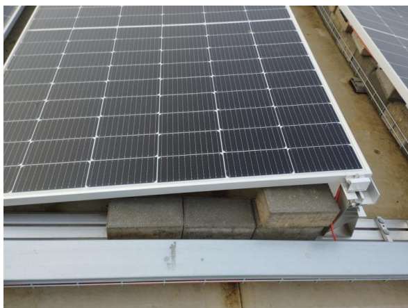
Ilustración 13 Lastres del módulo (Enerland)
