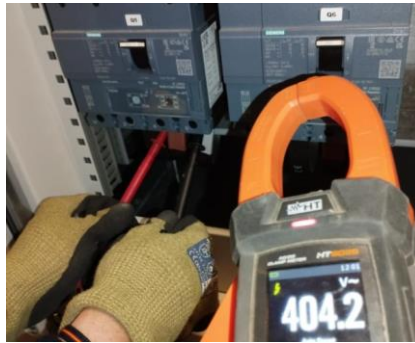
Ilustración 19 Medición del cuadro de corriente alterna (Enerland)
