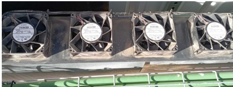
Ilustración 11 Ventiladores del inversor (Enerland)
