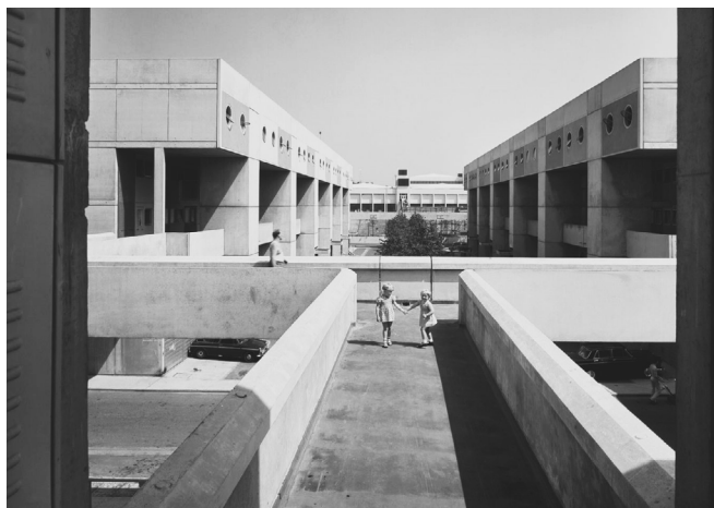
Fig. 42. Southgate Estate , Runcorn, James Stirling,1977. Pasarela comunicando dos bloques, 1979
