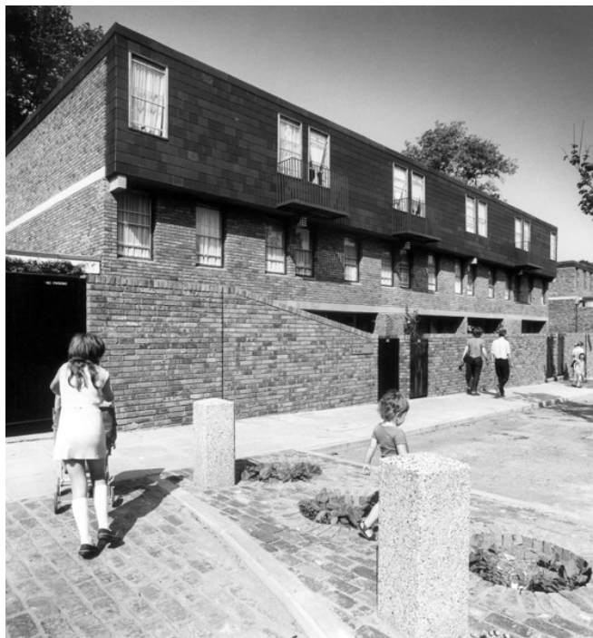
Fig. 30. Marquess Road Estate, Londres, Darbourne & Darke, 1966. Bloque de tres alturas, 1980
