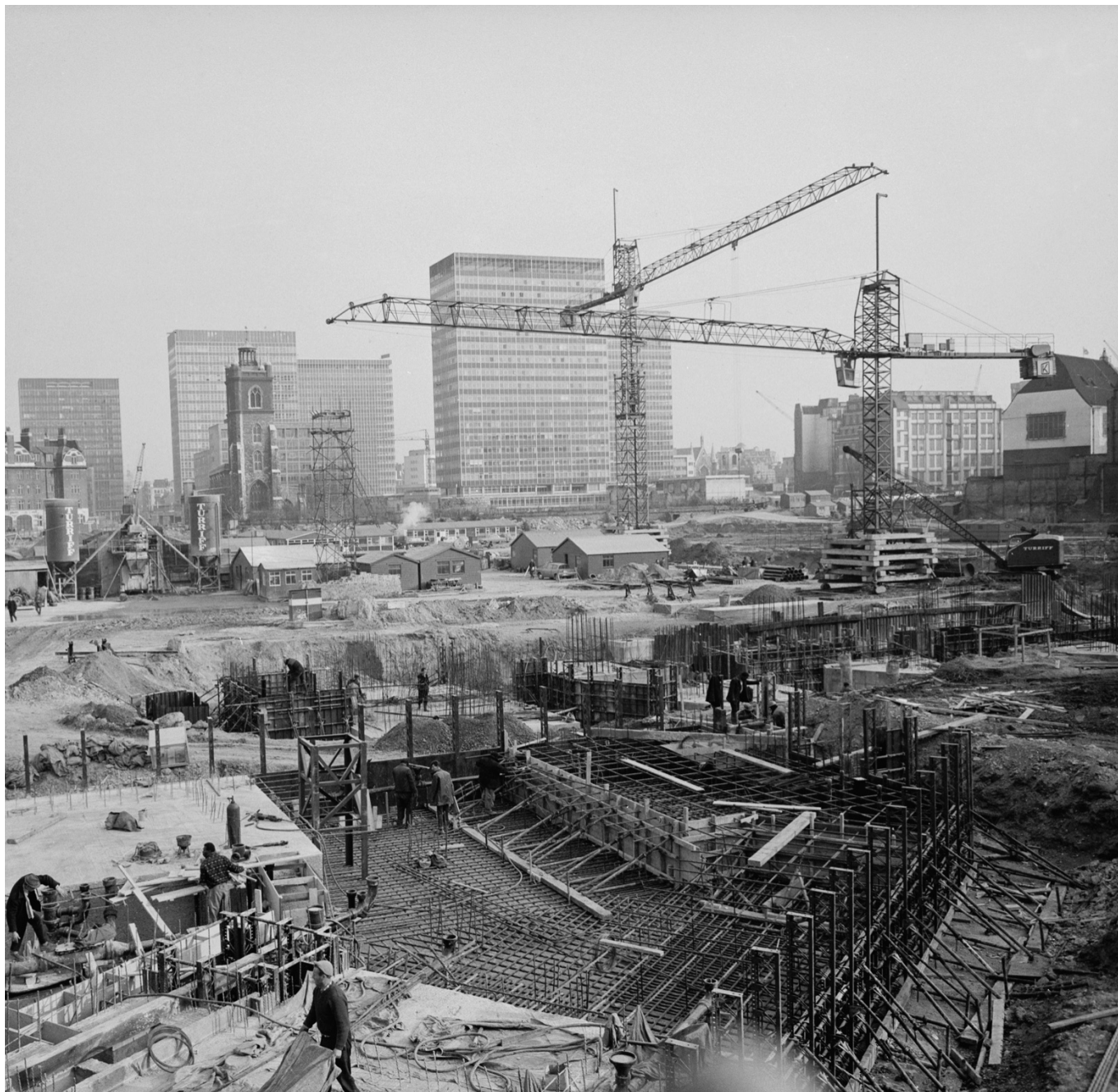
Fig. 5. Construcción de torres en el centro de Londres. 1962
