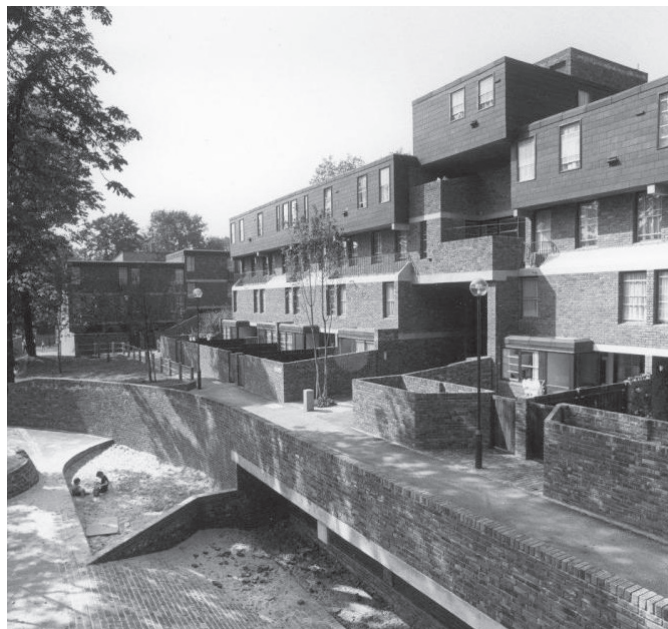
Fig. 21. Marquess Road Estate, Londres, Darbourne & Darke, 1966
