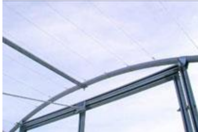
FIGURA 7: ELEMENTOS ESTRUCTURALES, SISTEMAS DE SUJECCIÓN DE LA CUBIERTA
