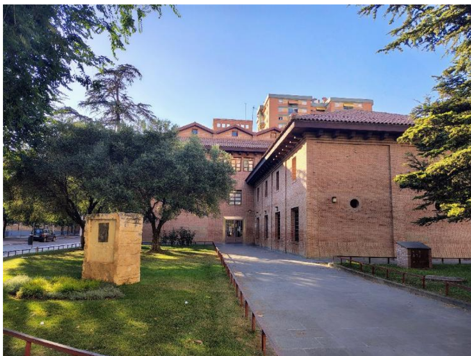
Ilustración 29. Exterior de la Biblioteca Pública de Huesca, 2025
