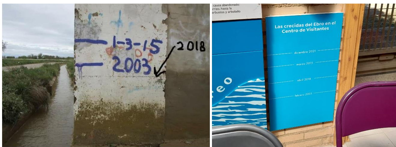
Fotos 4 y 5. Limnimarcas de Luceni (izq.) y del Galacho de Juslibol (dcha.). Fuente: Alfredo Ollero.
