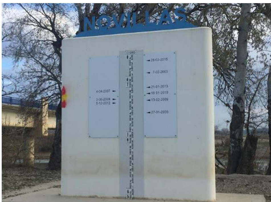
Foto 1. Limnimarca de Novillas. Fuente: Alfredo Ollero.
