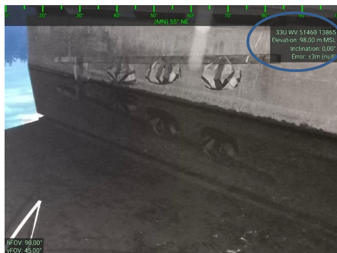
Ilustración 10. Fotografía de cargas simuladas a los pies de un puente con metadatos.
