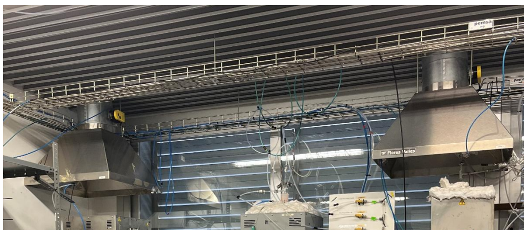
Figura 16. Campanas extractoras del laboratorio.
