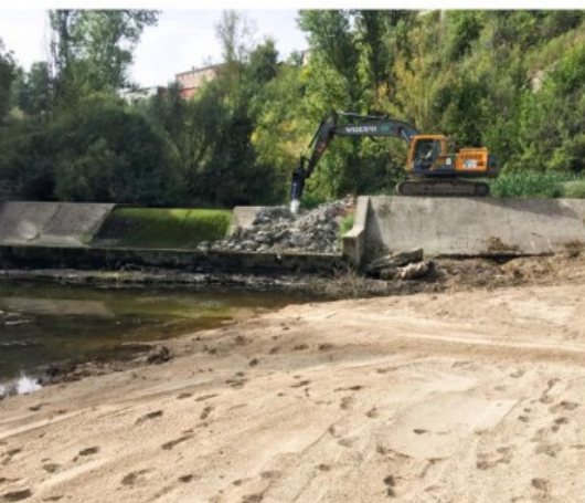
Figura 3. Derribo de una presa en el río Adaja (Árvalo); en España se han derribado más de 700.
