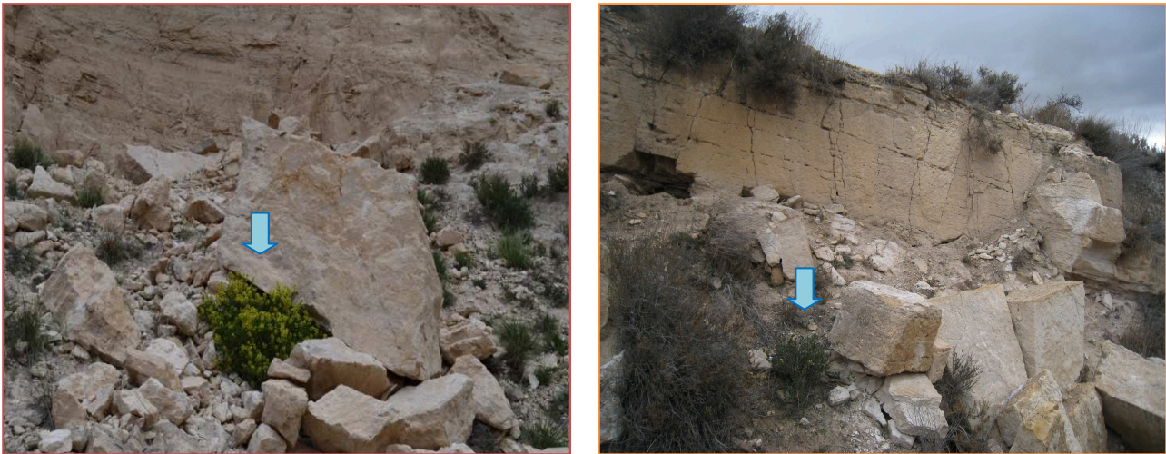
Figura 4.9. Ejemplar de crujiente, con buen desarrollo y floración, rodeado por bloques procedentes del descalzamiento del escarpe superior en el Barranco de La Hoz. Parte de la planta se encuentra bajo el bloque de mayor tamaño (izquierda). Derrumbe junto a plantón de refuerzo en el microambiente VB-V2a. Esta perturbación ha provocado la extinción de parte de la plantación (derecha).
