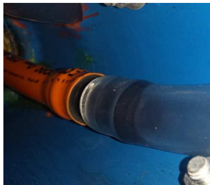
Figura 104: Detalle de la unión de la manguera de 16mm con la de 9 mm. Fuente propia
