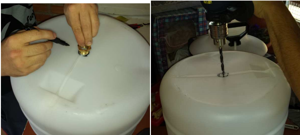
Figura 109: Colocación del manguito M-H 3/4"-1/2" en el tambor. Fuente propia
