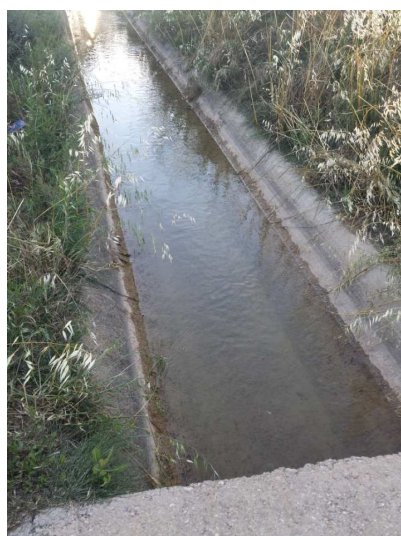
Figura 80: Lugar de bombeo. Fuente propia
