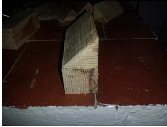
Figura 114: Disposición de los tacos con las cuñas. Fuente propia
