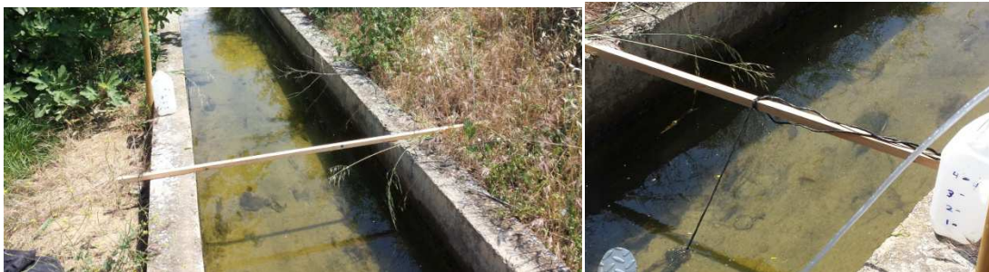
Figura 62: Foto del elemento de unión de la bomba. Fuente propia
