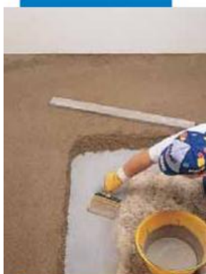
Aplicación de la lechada de adherencia para recrecidos de
