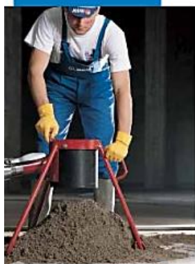
Suministro del mortero Topcem
