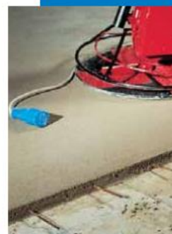
Acabado superficial con helicóptero
