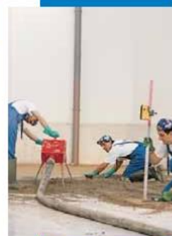
Aplicación de la mezcla de Topcem
