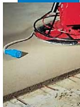
Acabado superficial con helicóptero
