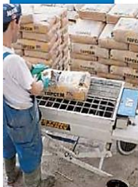
Mezcla de Topcem con mezclador con sinfín
