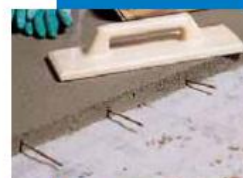
Detalle del recrecido con Topcem con las esperas de la junta de trabajo
