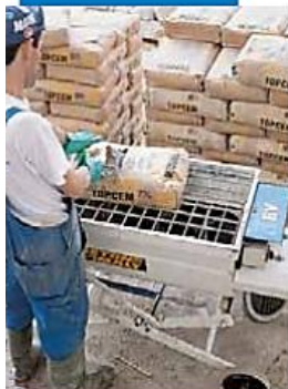
Mezcla de Topcem con mezclador con sínfin
