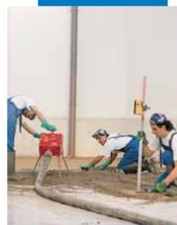
Aplicación de la mezcla de Topcem
