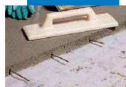
Detalle del recrecido con Topcem con las esperas de la junta de trabajo
