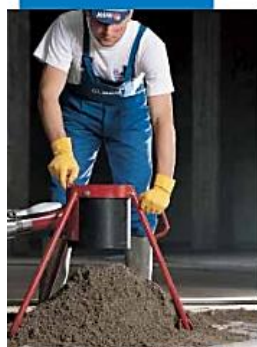
Suministro del mortero Topcem
