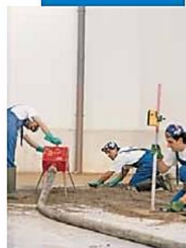
Aplicación de la mezcla de Topcem
