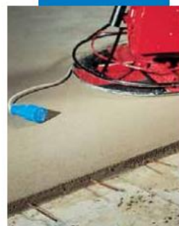
Acabado superficial con helicóptero
