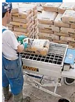
Mezcla de Topcem con mezclador con sinfín
