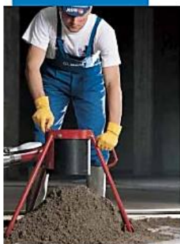
Suministro del mortero Topcem
