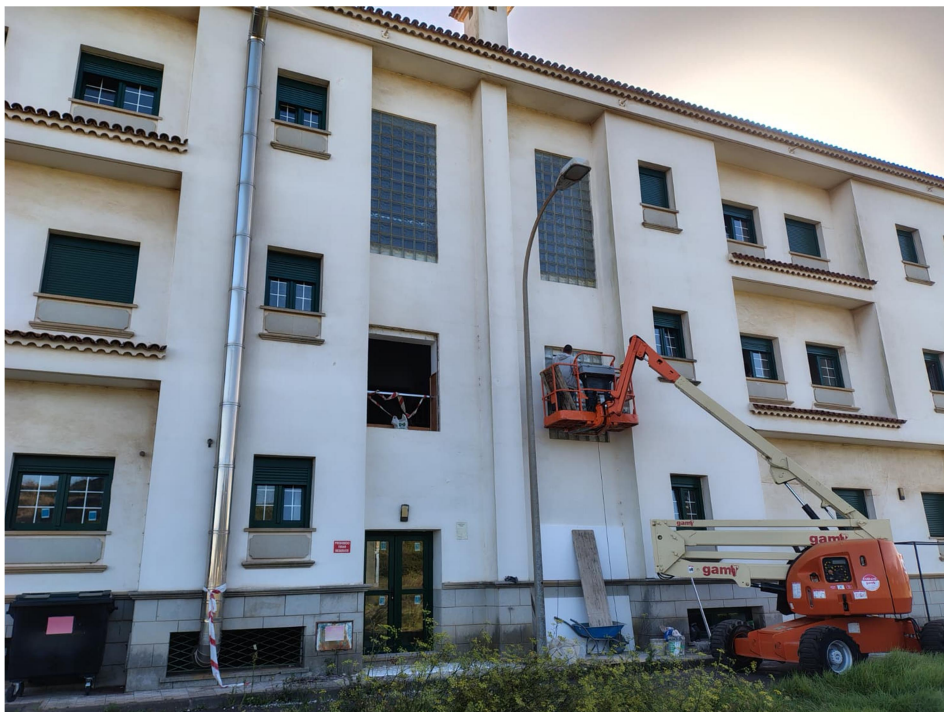
Figura IV.4. Instalación nuevas ventanas parte trasera edificio alojamiento. Fuente: Elaboración propia.
