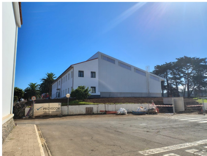
Figura 11. Nuevo edificio en el que se han instalado paneles fotovoltaicos. Fuente: Elaboración propia.
