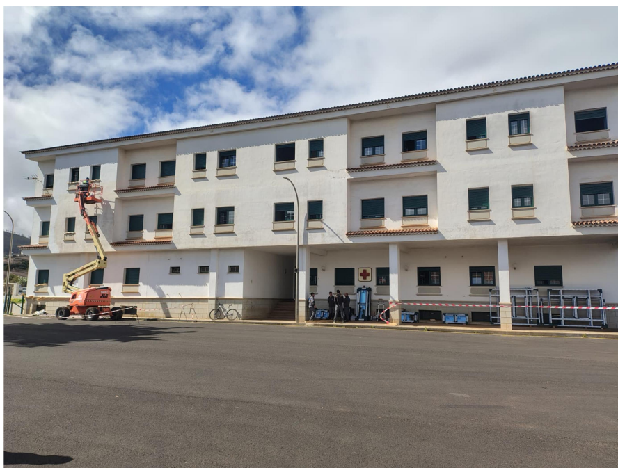
Figura IV.1. Instalación nuevas ventanas edificio alojamiento. Fuente: Elaboración propia.
