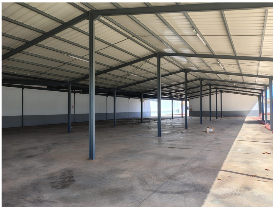
Figura III.4. Interior de tinglado. Fuente: Elaboración propia.
