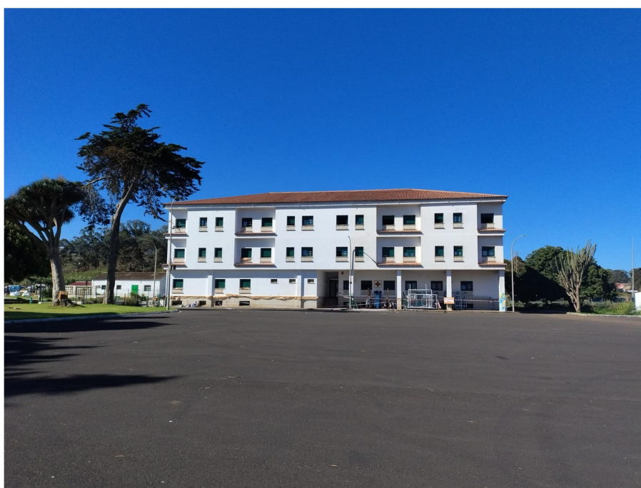
Figura IV.2. Vista general edificio alojamiento. Fuente: Elaboración propia.
