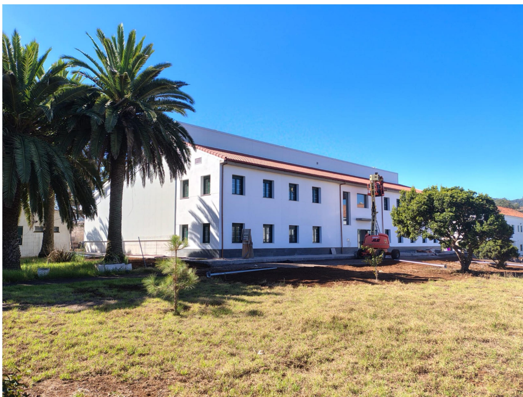
Figura III.6. Diferente vista edificio multiusos zona aulas y despachos. Fuente: Elaboración propia.
