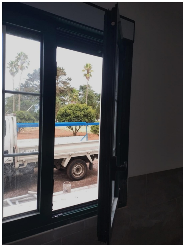
Figura 19. Nueva ventana instalada en nuevo edificio multiusos. Fuente: Elaboración propia.
