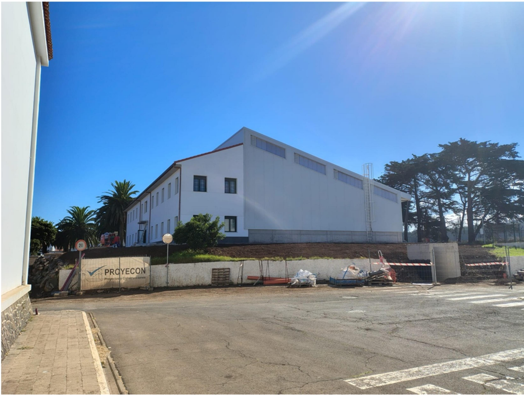
Figura III.9. Vista lateral edificio multiusos. Fuente: Elaboración propia.
