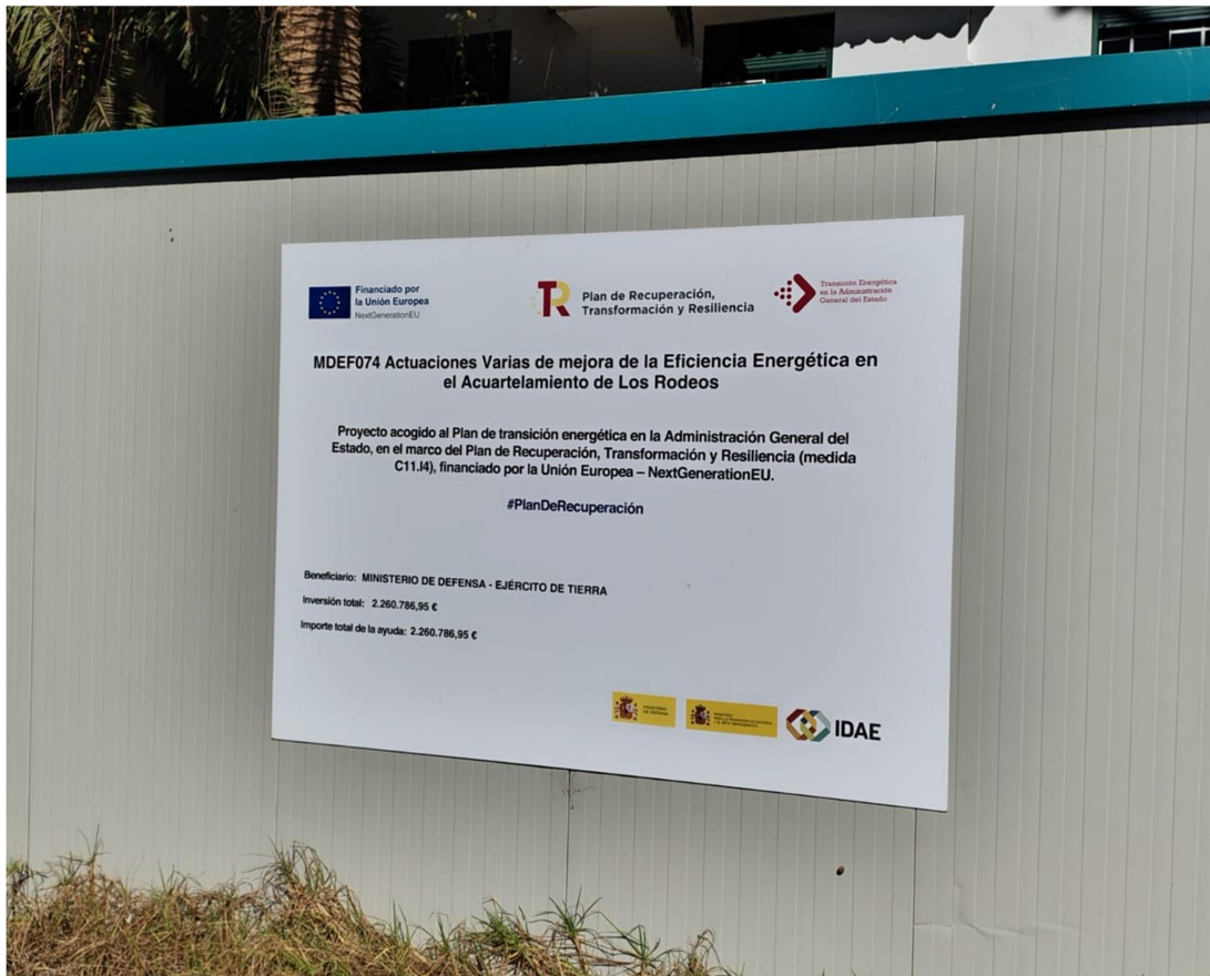
Figura I.1. Cartel anuncio obras del PMEE en el acuartelamiento 'Los Rodeos'. Fuente: Elaboración propia.
