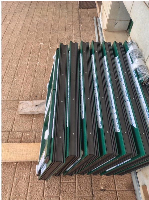
Figura 18. Nuevas ventanas antes de ser instaladas. Fuente: Elaboración propia.
