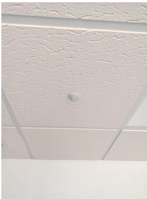
Figura 21 . Fococélula inhibidora instalada en zona común nuevo edificio multifunción. Fuente: Elaboración propia.
