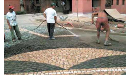
Fig. 50. Fase final de limpieza.
