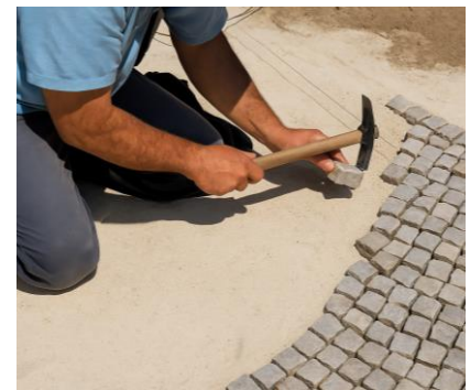
Fig. 44. Colocación manual de las piedras.
