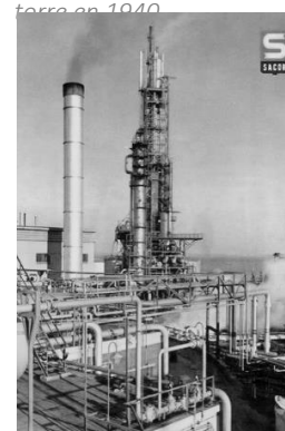
Fig. 121. Imagen de la torre después de la ampliación de la refinería.
