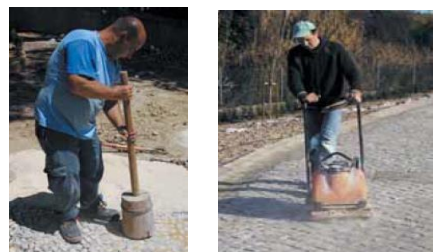
Fig. 49. Trabajadores compactando el terreno.
