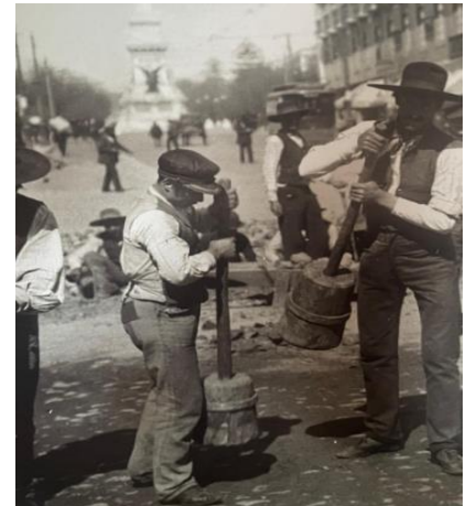
Fig. 40. Calceteiros trabajando la calçada a principios del S XX en Lisboa.
