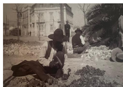
Fig. 39. Calceteiros trabajando la calçada a principios del S XX en Lisboa.
