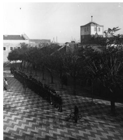
Fig. 9. Pavimento en el Patio de Armas del Castillo de San Jorge.
