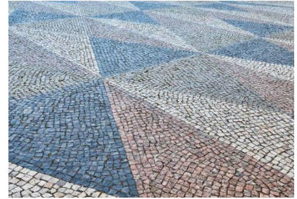
Fig. 33. Pavimento de calçada portuguesa en el que se usan 3 tonalidades: Negro, blanco y rosado.
