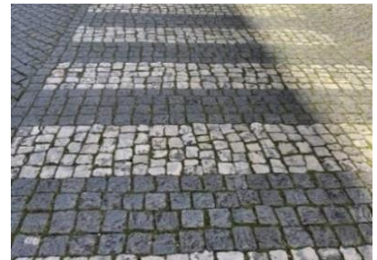
Fig. 34. Vía rodada en Coímbra. Piedras de 10-12 cm aproximadamente.
