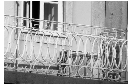
Fig. 109. Barandilla de un balcón de la plaza del Toural, en la cual se inspira Jotta.
