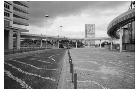
Fig. 98. Toma a pie de calle del proyecto del proyecto de Pedro Calapez en la entrada sur de expo'98.
