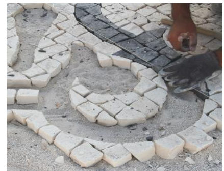
Fig. 45. Calceteiro colocando las piedras una vez se ha eliminado el molde.
