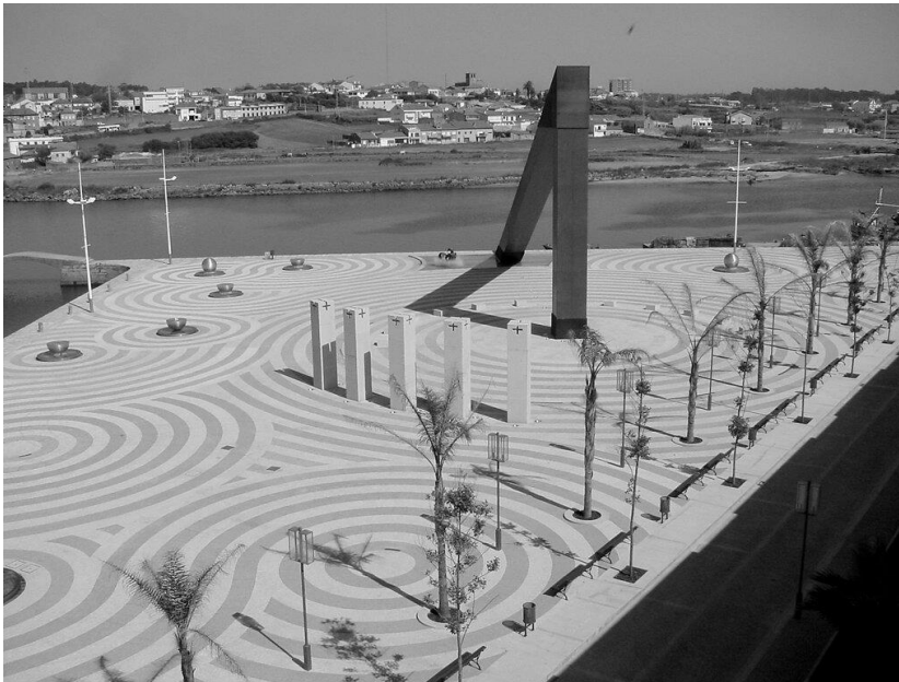
Fig. 125. Imagen vista general de la plaza.
