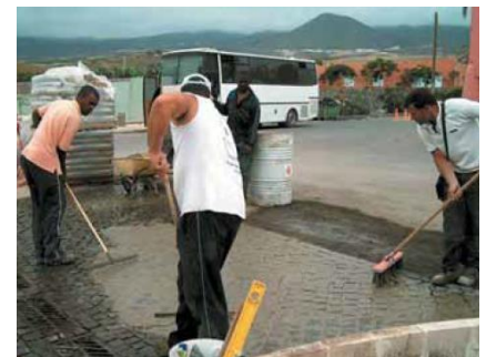
Fig. 48. Trabajadores sellando las juntas con cemento.
