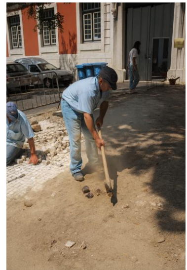
Fig. 42. Operario trabajando en la primera fase.
