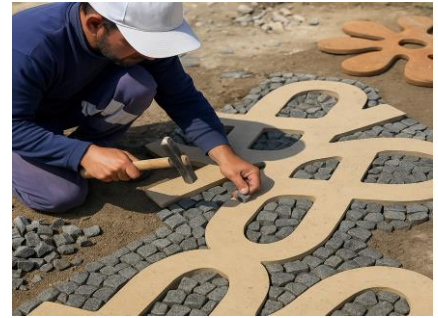
Fig. 46. Ejecución de una calçada con molde de madera.
