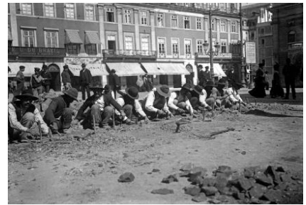
Fig. 11. Grupo de calceteiros trabajando en la Plaza Dom João da Câmara, Lisboa (1907).
