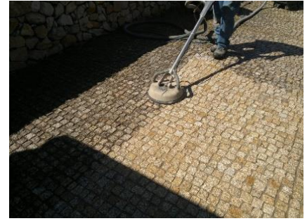
Fig. 66. Limpieza de una calçada portuguesa con maquinaria de presión para recuperar su brillo y buen estado.
