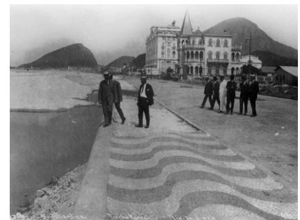
Fig. 12. Obras del paseo marítimo con pavimento ondulado en Río de Janeiro.
