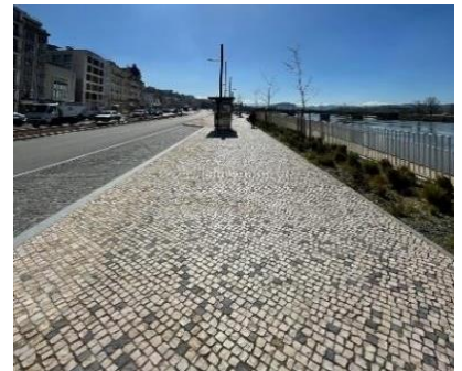
Fig. 35. Acera de Coímbra en referencia al tamaño de los adoquines. Piedras de 5-7 cm.
