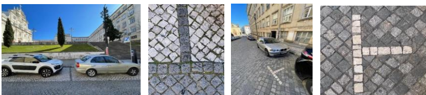
Fig. 71. Líneas de delimitación de aparcamiento trazadas con contrastes de blanco y negro propios de la calçada.
