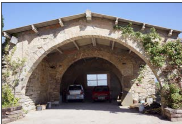
Fig. 4. Aventador de casa Lueza en Abizanda (Foto: autores).
