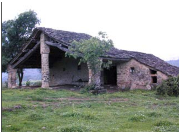
Fig. 11. Vista general del aventador de Sarratiás, adosado a la fachada del pajar (Foto: autores).
