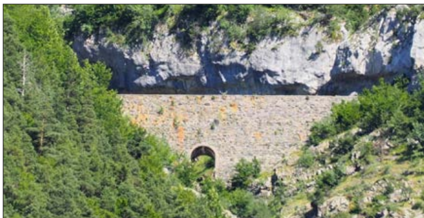
Fig. 2. Estructura defensiva denominada «dique vacío» por su inventor Benito Ayerbe. Se sitúa en el torrente de Epifanio, con su gran mechnal central de 4 m de luz y 10 m de altura. Foto: David Ibáñez.
