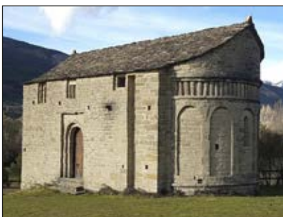
Fig. 2. Estado actual de la ermita la cual ha sido intervenida por Amigos de Serrablo en seis ocasiones: 1974, 1977, 1989, 2003, 2008 y 2013. Foto: Archivo Amigos de Serrablo.
