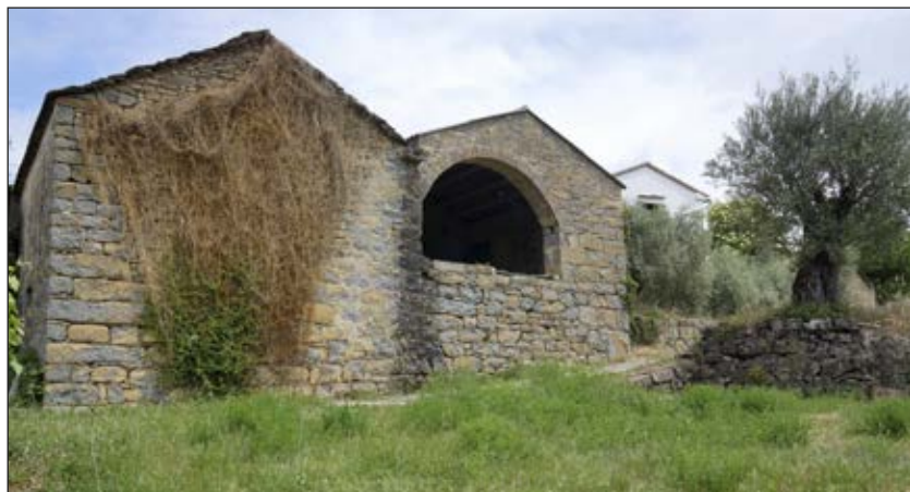
Fig. 3. Aventador con arcos de casa Felices de Guaso, visto desde el exterior de la era (Foto: autores).
