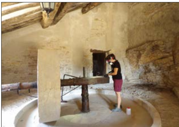
Fig. 7. Tratamiento contra xilófagos en Molino de Betorz. Foto: RMS, 2024.
