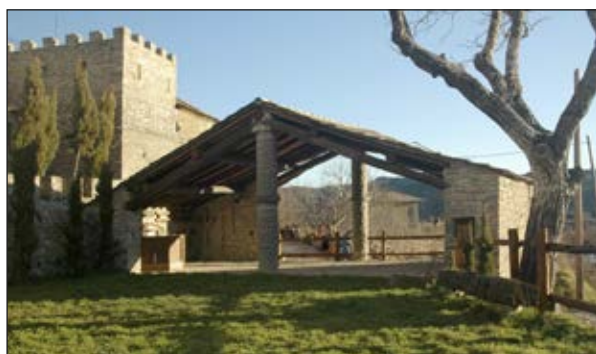
Fig. 2. Aventador de casa Senz de Latorrecilla, cuya parte central está reforzada mediante columnas (Foto: autores).
