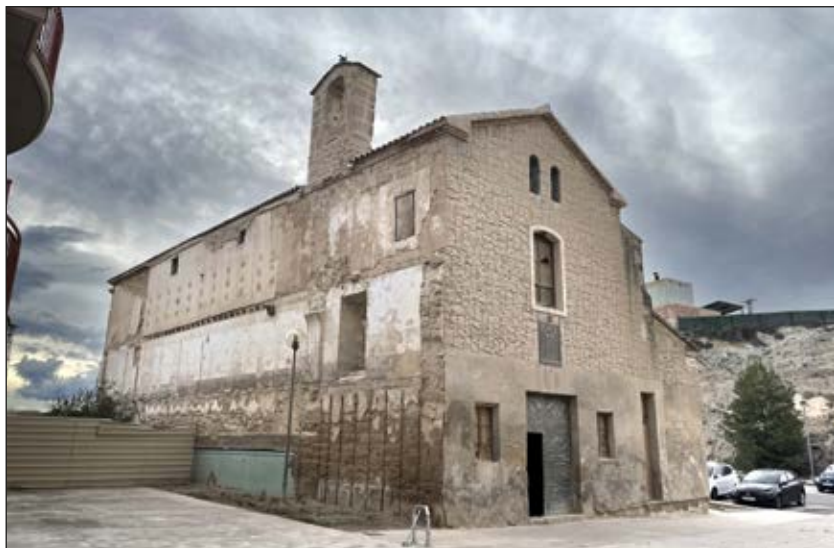
Fig. 1. Alcañiz (Teruel). Convento de capuchinos. Exterior. Fotografía: Jorge Martín Marco.
