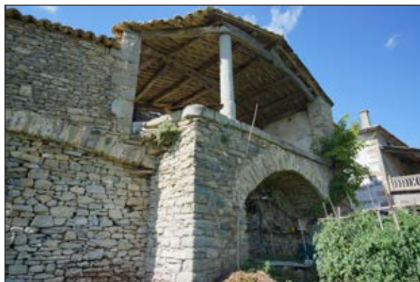
Fig. 8. Trasera del avental de casa Pardina de Almazorre (Foto: autores).
