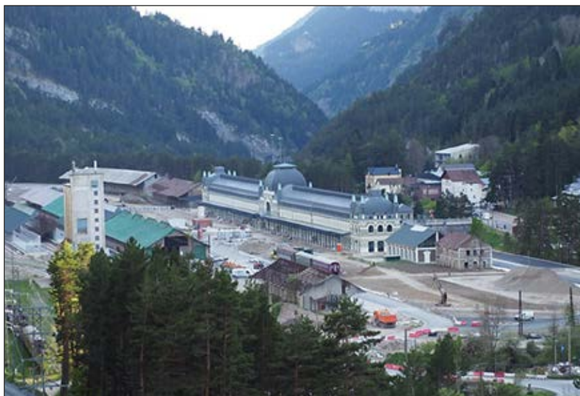
Fig. 9. Aspecto general de la estación, en obras de rehabilitación para su reapertura. Foto: David Ibáñez.
