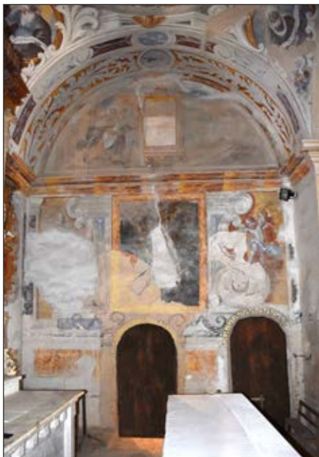
Fig. 7. Muro lateral derecho con la Resurrección. Fotografía autor.
