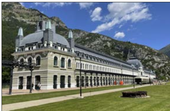
Fig. 14. Vista posterior de la Estación Internacional de Canfranc, acondicionada como hotel. Julio 2024. Foto de las autoras.
