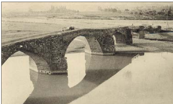
Fig. 11. Puente de Tiermas: ubicado sobre el cauce del río Aragón, junto al balneario. Con la construcción del embalse quedó sumergido y sus ruinas afloran cuando el nivel de las aguas desciende. Comunicaba Tiermas y la carretera nacional en la margen derecha, lado en el que conservaba las arcadas de piedra, con los caminos que llevaban, en la otra orilla, a Ruesta, flanco que tuvo que ser reconstruido en numerosas ocasiones. Imagen: colección de la autora.
