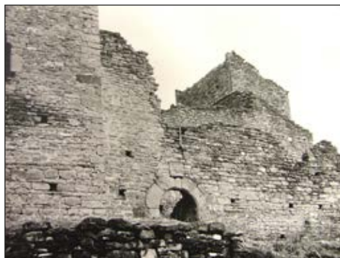
Fig. 7. Estado del castillo de Larrés, donde se aprecia la puerta principal, la sala de arcos apuntados y la torre sur (1977). Foto: Archivo Amigos de Serrablo.
