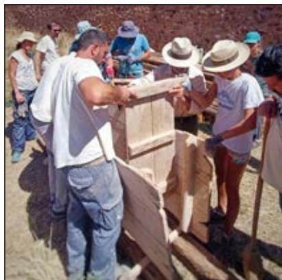
Figs. 13 y 14. Montaje de un tapial durante el taller de restauración de muros de tapia de julio de 2024. Los miembros de la junta directiva de la Asociación Fuset por el Patrimonio Rural junto con Raúl Gimeno y Pepe Rodrigo (en el centro de la imagen).
