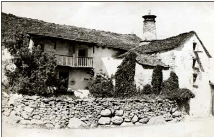
Fig. 2. Estado de casa Batanero antes de la restauración, 1972. Fotografía: Archivo Asociación «Amigos de Serrablo»).
