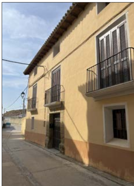
Fig 1. Fachada de Casa López, Alcalá de Gurrea.
