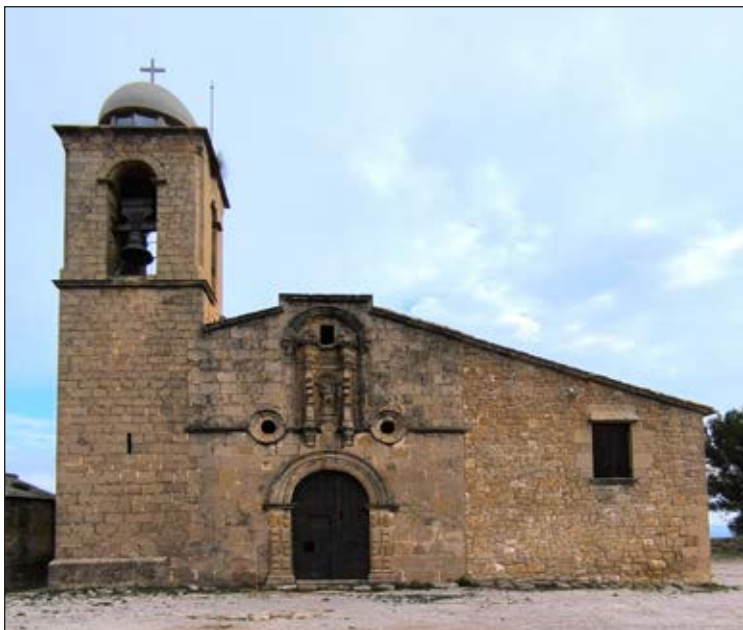
Fig. 1. Ermita de San Cristóbal de Calaceite. Fotografía autor.
