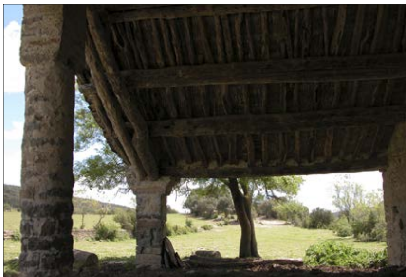
Fig. 12. Detalle de los soportes del aventador de Sarriatiás (Foto: autores).
