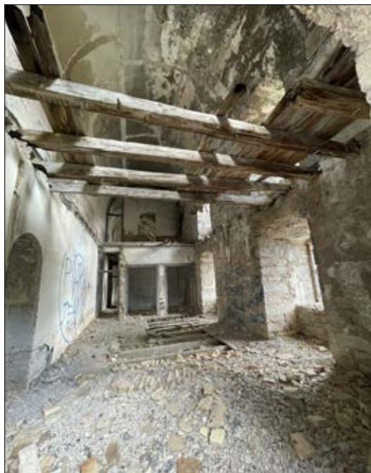
Fig. 11. Vista interior del pabellón principal del fuerte Coll de Ladrones, Canfranc. Julio 2024. Foto de las autoras.
