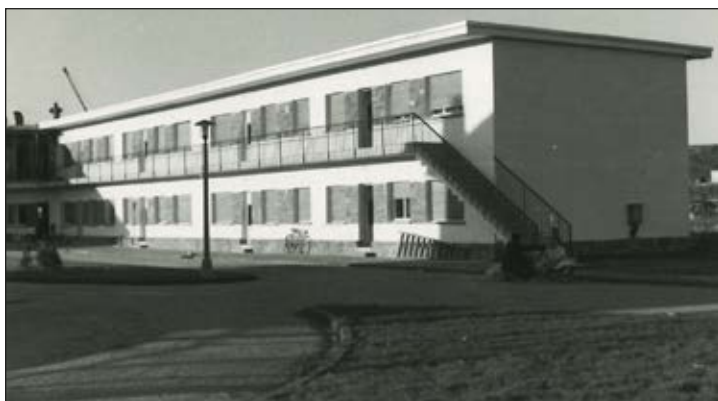
Fig. 11. Vista parcial del edificio de viviendas para los trabajadores de la factoría, hacia 1968 (ABAU).
