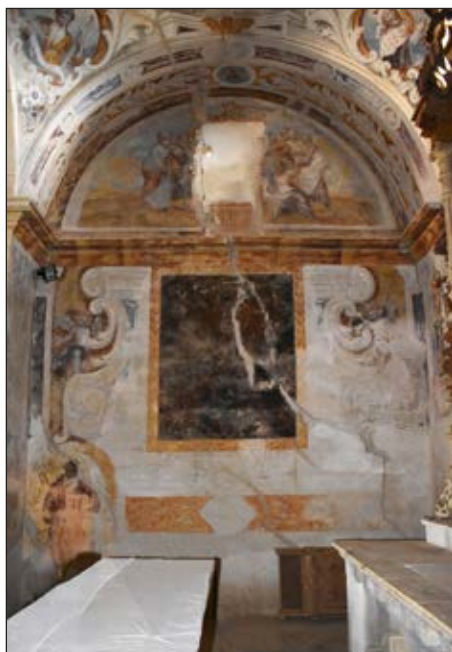
Fig. 6. Muro lateral izquierdo con la Ascensión. Fotografía autor.
