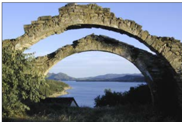
Fig. 1. Aventador de Gerbe, abierto mediante arcos, antes de su restauración (Foto: autores).
