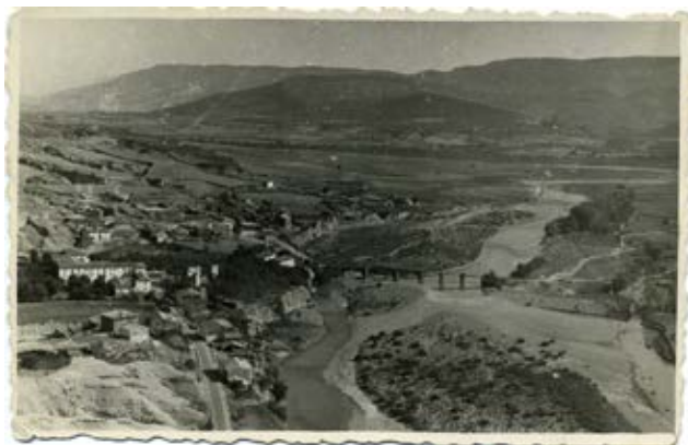
Fig. 2. Balneario de Tiernas (izquierda) y algunas casas junto al río Aragón. Se puede apreciar el trazado de la antigua carretera, que discurría desde Jaca a Pamplona, y el puente sobre el cauce fluvial, para conectar el camino con dirección a Ruesta en la margen izquierda. Todo ello desaparecido tras ser cubierto por las aguas del embalse de Yesa. Imagen: Asociación Pro-Defensa de Tiernas.
