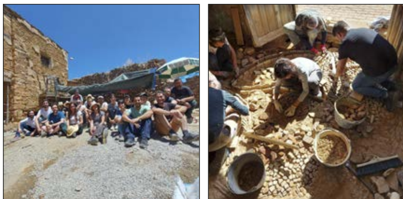
Figs. 3 y 4. Participantes en el primer taller de empedrados, celebrado en junio de 2022. Restauración del motivo geométrico del sello de Salomón que decora la entrada de la casa solariega de los Ibáñez de Bernabé de Used, durante el segundo taller de empedrados (octubre de 2022).
