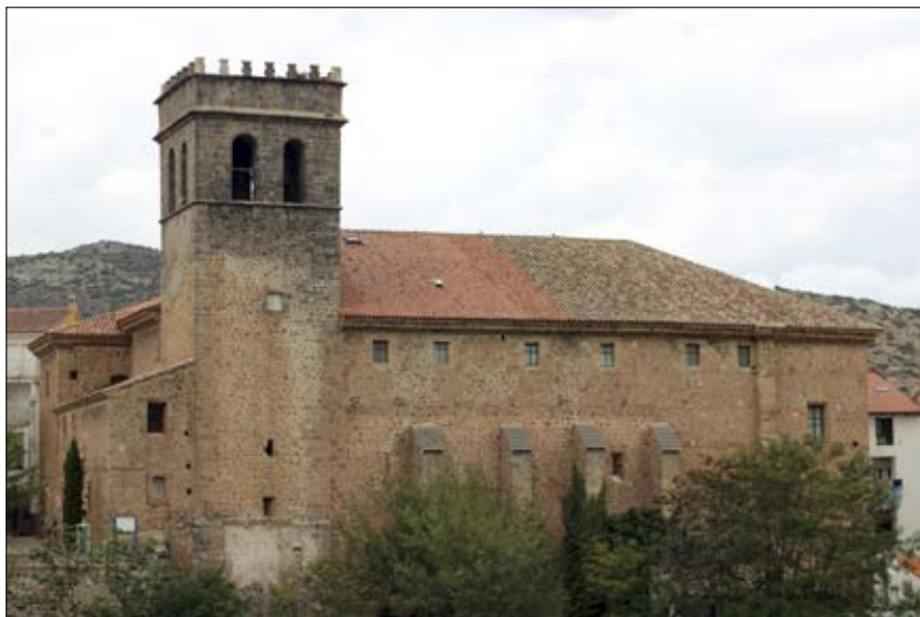
Fig. 1. Muro sureste de la iglesia del Salvador de Manzanera en el que, en la parte de los contrafuertes, se aprecian las dimensiones del templo medieval. Fotografía: autor, 2024.
