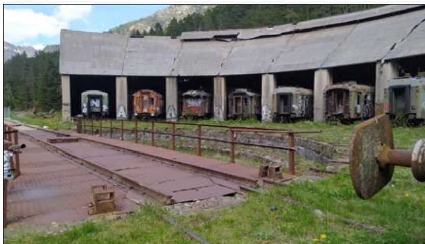
Fig. 5. Depósito de locomotoras y puente giratorio. Esta estructura proyectada por el ingeniero José Roselló Martí, se concluyó en 1926 y se sitúa en la zona sur de la explanada. El depósito se encuentra actualmente en fase de rehabilitación para adaptarlo a su nueva función como una de las tres sedes del futuro Museo del ferrocarril en Aragón, junto con la estación de Caminreal-Fuentes Claras, en Teruel y otra sede por determinar en la provincia de Zaragoza. Foto: Raquel Carcas.
