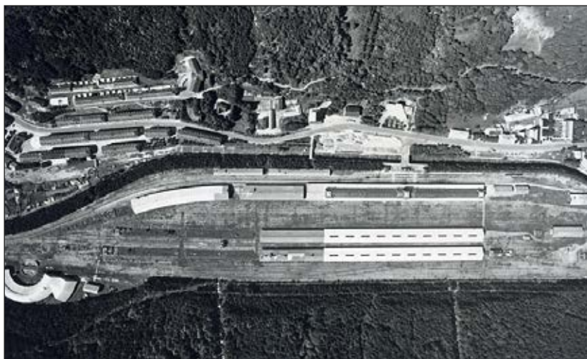
Fig. 1. Vista aérea de las infraestructuras ferroviarias y la localidad de Canfranc-estación en 1973. En la parte izquierda de la imagen se observan los 25 edificios que componían el original poblado industrial de Los Arañones, construido por el Gobierno para alojar a los funcionarios que darían servicio a la estación. Foto: Fundación de los Ferrocarriles Españoles.
