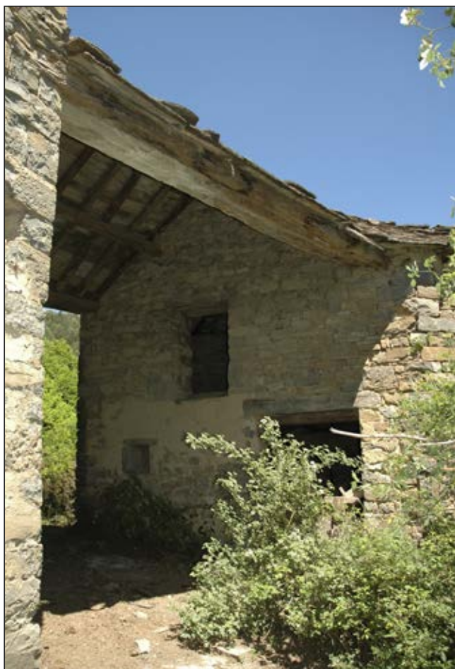
Fig. 15. Espacio adaptado como aventador en el acceso a una era en Cajol (Foto: autores).
