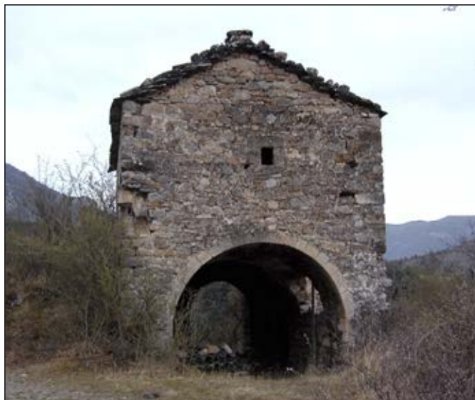
Fig. 6. El desaparecido aventador de Aguascaldas, con el pajar superpuesto sobre él conformando un único edificio (Foto: autores).
