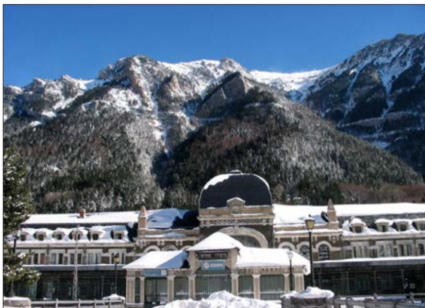
Fig. 4. Edificio principal de la Estación de Canfranc, denominado «de Servicio» en el Proyecto original, de Fernando Ramírez de Dampierre, antes de su rehabilitación a partir de 2006. Foto: David Ibáñez
