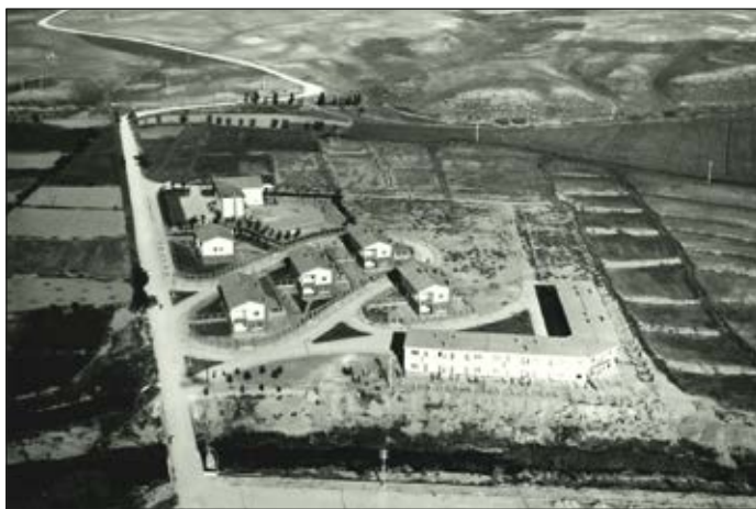
Fig. 9. Vista del poblado Foret con las viviendas para los trabajadores con planta en L, hacia 1965 (ABAU).
