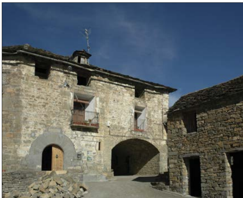
Fig. 16. Fachada de casa Coscojuela de Charo, con paso cubierto sobre la calle usado como aventador (Foto: autores).
