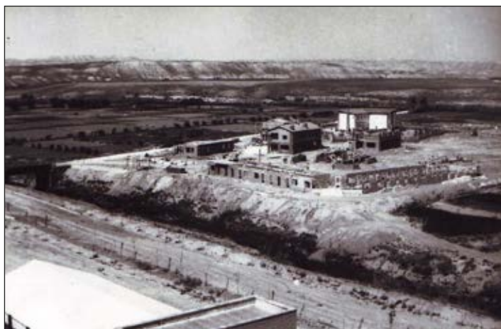
Fig. 6. Vista general del poblado Foret durante su construcción, hacia 1963 (Fondo Documental de la Comarca de la Ribera Baja del Ebro).
