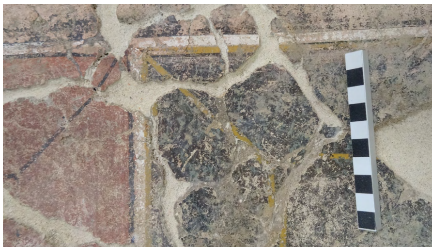
FIGURA 5. Detalle de los paneles del zócalo. Imitación del mármol serpentino realizada a esponja (dcha.) (Fotografía L. Íñiguez y E. Voltan)
