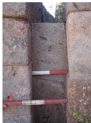
FIGURA 12. Sección tipo del canal. Salto hidráulico
