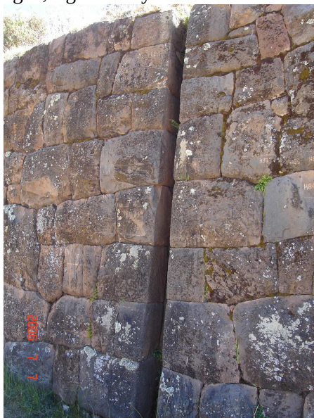
FIGURA 16. Canal empotrado en talud del andén
