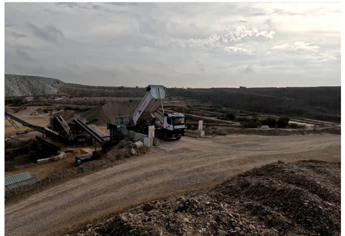
Figura 9: Posición de descarga en tolva.
