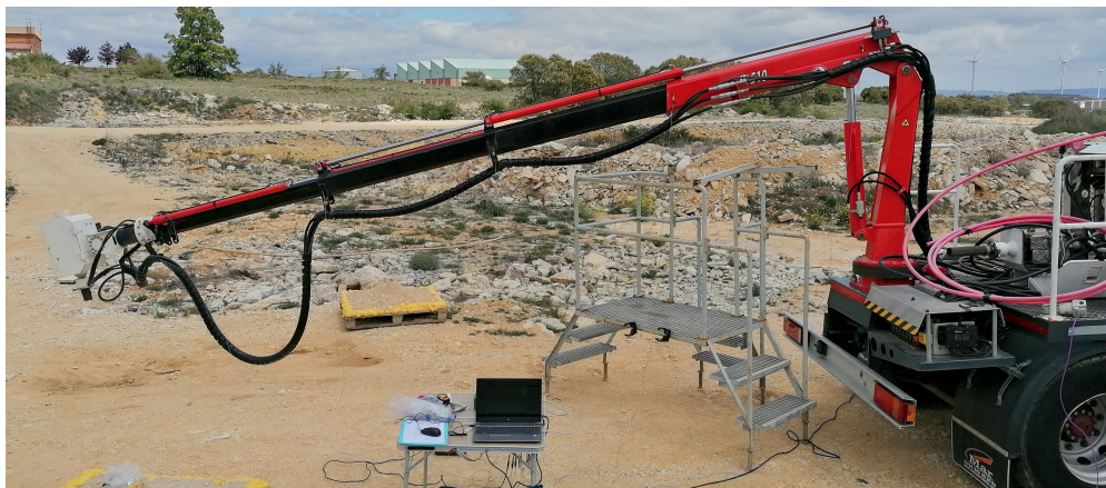
Figura 1: Grúa hidráulica sobre la que se realiza el control
