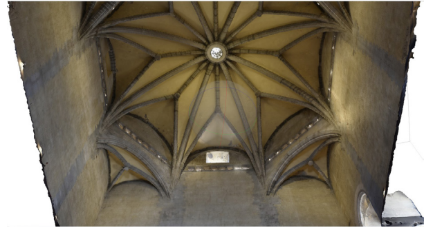
Fig. 13. Guillem Sagrera. Detalle del encuentro de los nervios con el muro, Lonja de los Mercaderes, Palma de Mallorca (fotografía de los autores).
