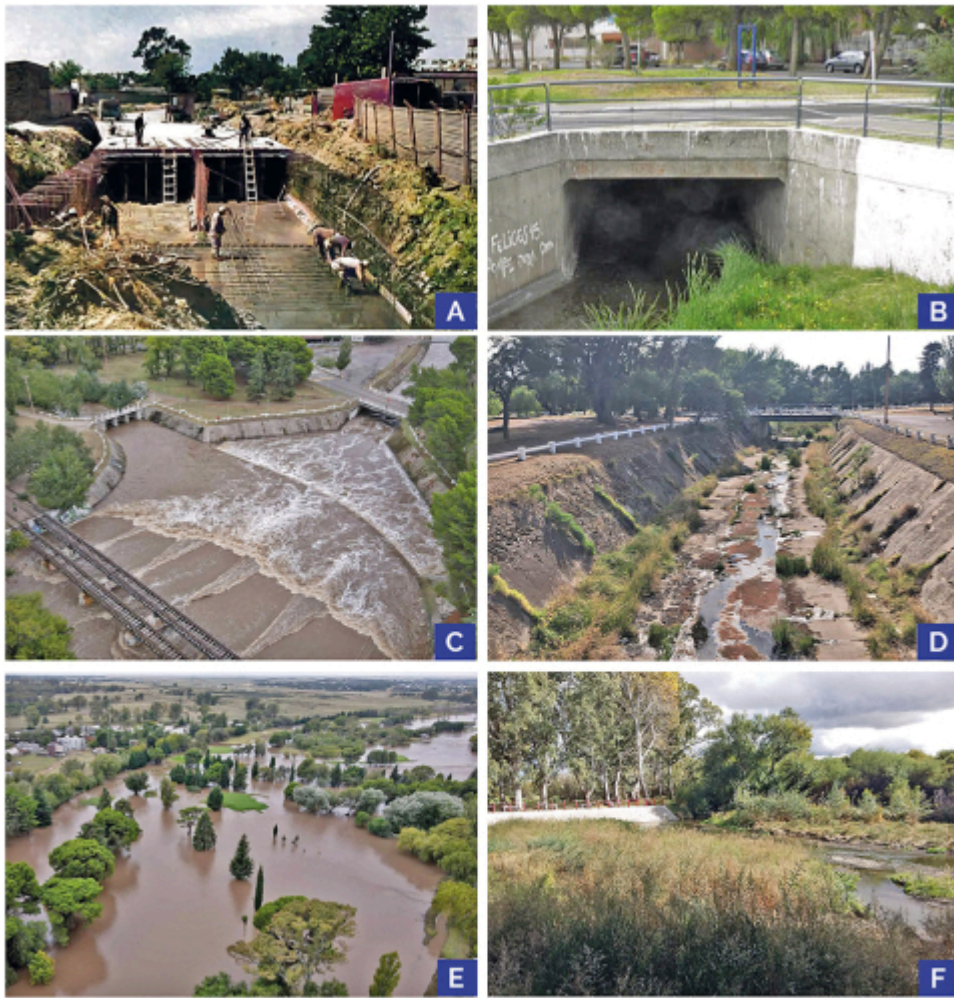
Fotografías: (A) Entubado urbano del arroyo Napostá en 1972. (B) Entubado urbano y Paseo de las Esculturas en 2021 (La Nueva, 2021). (C) Canal derivador Maldonado en la última crecida de 2022 (La Nueva, 2022). (D) Canal Maldonado en estado de estrechamiento por invasión vegetal (La Brújula, 2022). (E) Vista aérea de los barrios del periurbano norte afectados por inundaciones de la última crecida del 2022 (La Nueva, 2022). (F) Muro de contención erosiva de la margen izquierda del arroyo en sector periurbano norte (Pirchi, 2019).
