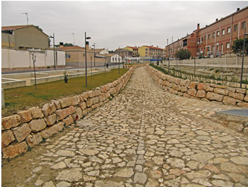
Figura 1 – Actuación urbana convencional en un cauce de hidrología efímera, con canalización y diseño de dos pequeños paseos a los lados. Barranco de las Casas en Puebla de Alfindén (Zaragoza)
