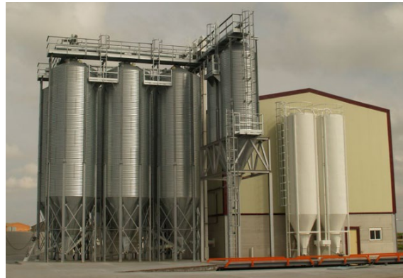
Figura 4. Diferentes silos de almacenamiento [21]
