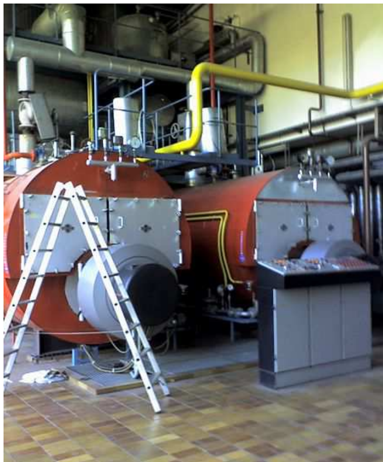
Figura 4. Calderas de vapor sujetas a reglamentación industrial.
