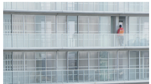
Figura 52. Ensamblaje paneles térmicos.
