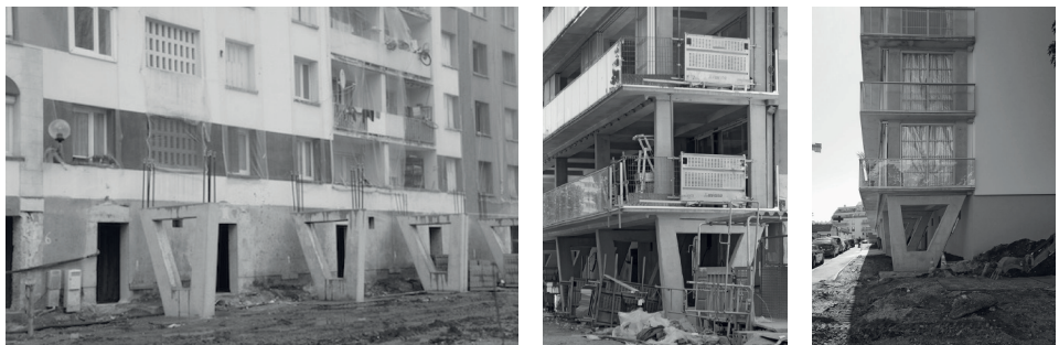
Figura 48. Imágenes del proceso constructivo de la estructura.
