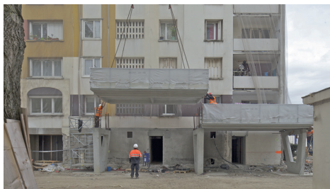
Figura 51. Montaje módulo.
