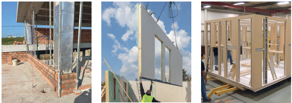
Figura 33. Comparación de sistemas constructivos in situ, prefabricado parcialmente y prefabricado en su totalidad.
