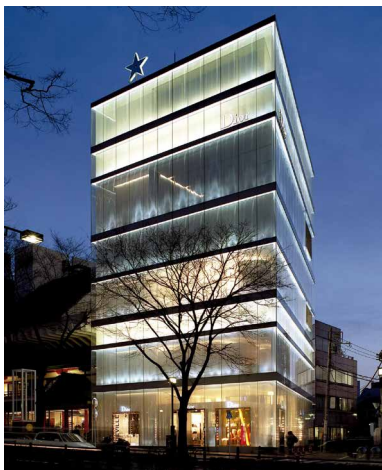
Fig. 27. Edificio Dior en Omotesandō, Tokio. SANAA, 2003.
