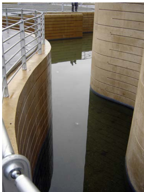
Fig. 4.116 – Detalle de la alberca que rodea el edificio
