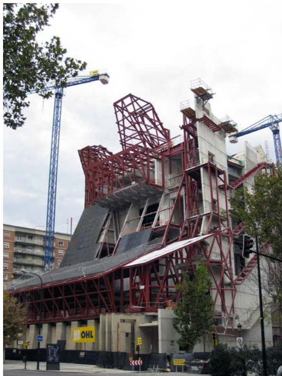
Figura 4.67 – Obras de ampliación. Noviembre de 2009
