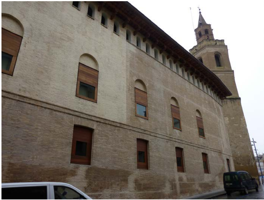
Figura 4.9 – Fachada lateral del conjunto hacia la calle Palacio, tras la remodelación
