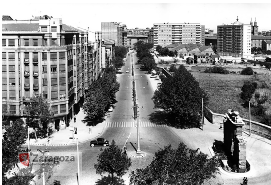
Figura 4.55 – Vista del paseo de María Agustín en torno a 1950. Al fondo, a la derecha, los talleres Pignatelli (fotografía: Ayuntamiento de Zaragoza, archivo Arribas)
