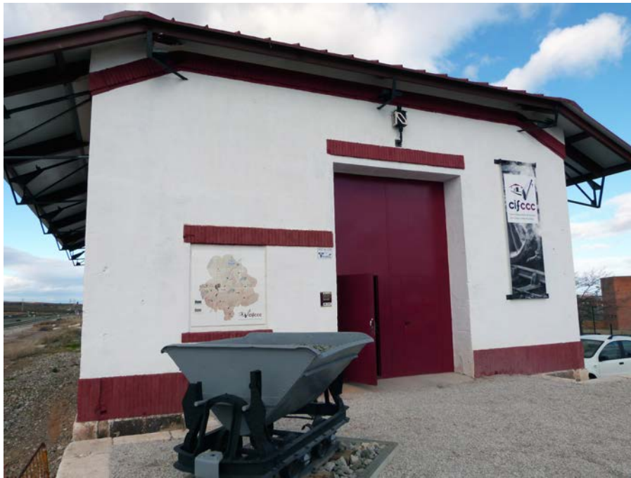
Figura 3.157 – Almacén ferroviario, sede del Centro de Interpretación del Ferrocarril de la Comarca Campo de Cariñena (Zaragoza)
