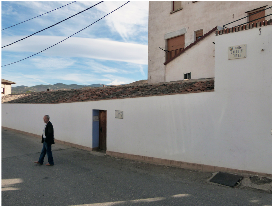
Figura 3.130 – La Casa Museo del Aceite de Aniñón (Zaragoza). Aspecto externo del edificio del molino
