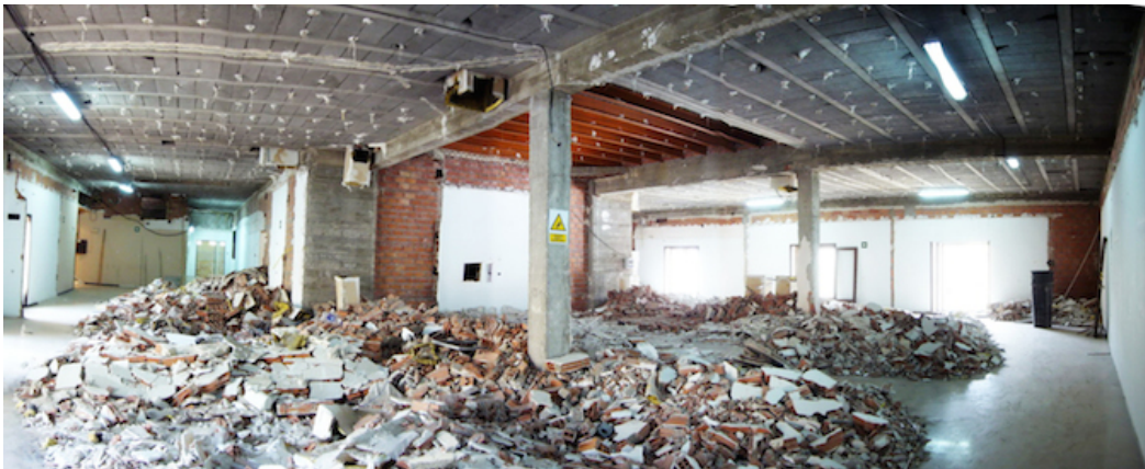
Figura 4.30 – Estado de la planta tercera, una vez eliminada la tabiquería existente. En el centro es posible apreciar la ubicación del patio, hasta entonces cegado. (Fotografía: Cuadrifolio)
