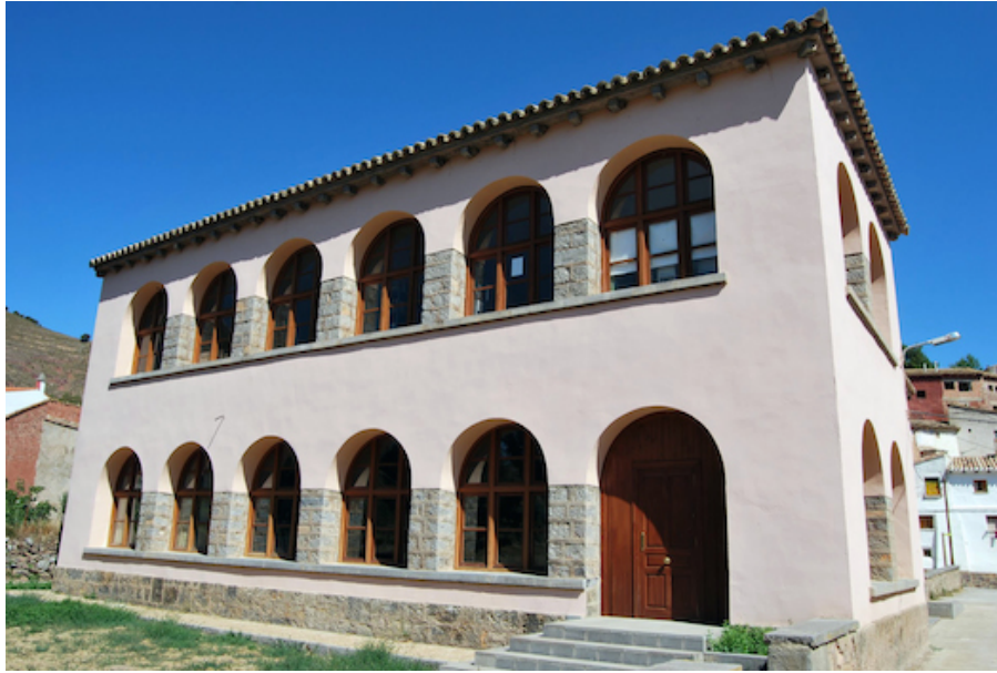
Figura 3.57 – Grupo Escolar “Severino Aznar” de Calcaena (Zaragoza), sede del Centro de Interpretación de la Naturaleza
