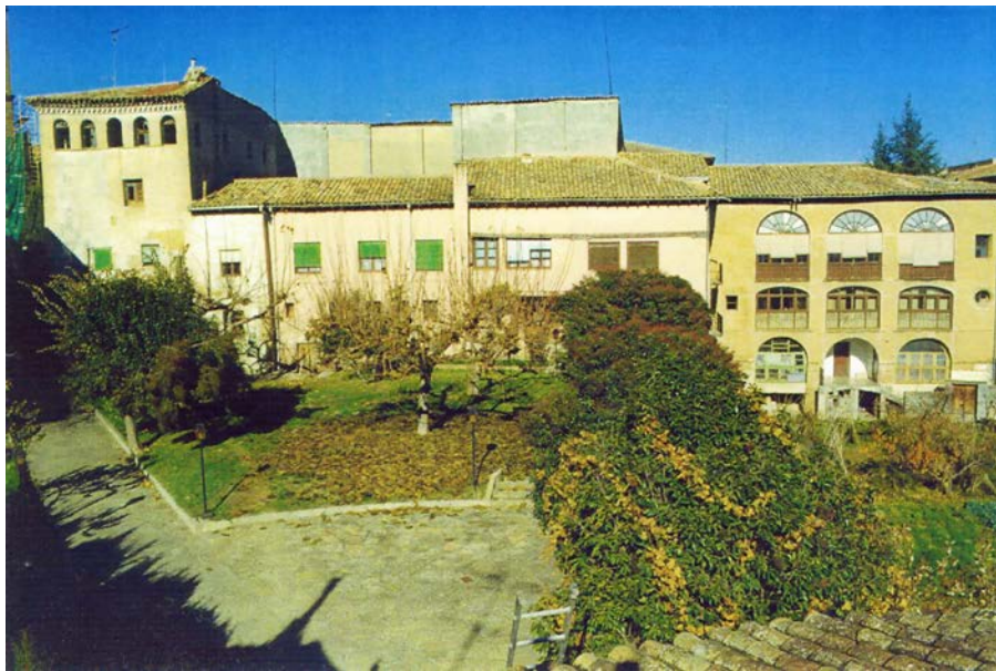
Figura 4.6 – Fachada del antiguo palacio episcopal hacia el jardín y el huerto. (Fotografía: José Miguel Ferrando)
