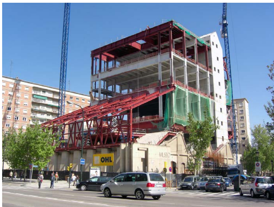
Figura 4.65 – Obras de ampliación. Abril de 2009
