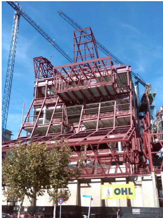
Figura 4.66 – Obras de ampliación. Septiembre de 2009
