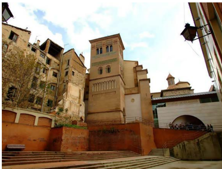
Figura 4.110 – Estado de la plaza de los Amantes antes de la rehabilitación de la Casa Hinojosa (situada a la izquierda de la imagen)
