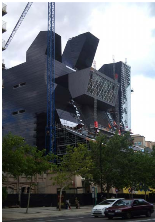
Figura 4.68 – Obras de ampliación. Junio de 2010
