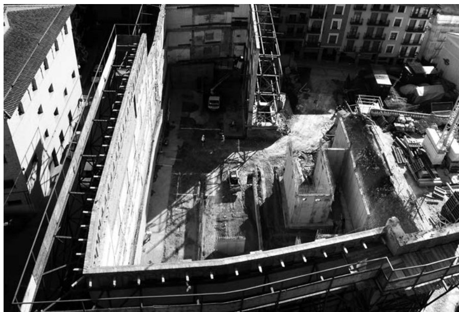
Figura 4.8 – Apeado de las fachadas y vaciado del palacio episcopal. (Fotografía: María Lalaguna)
