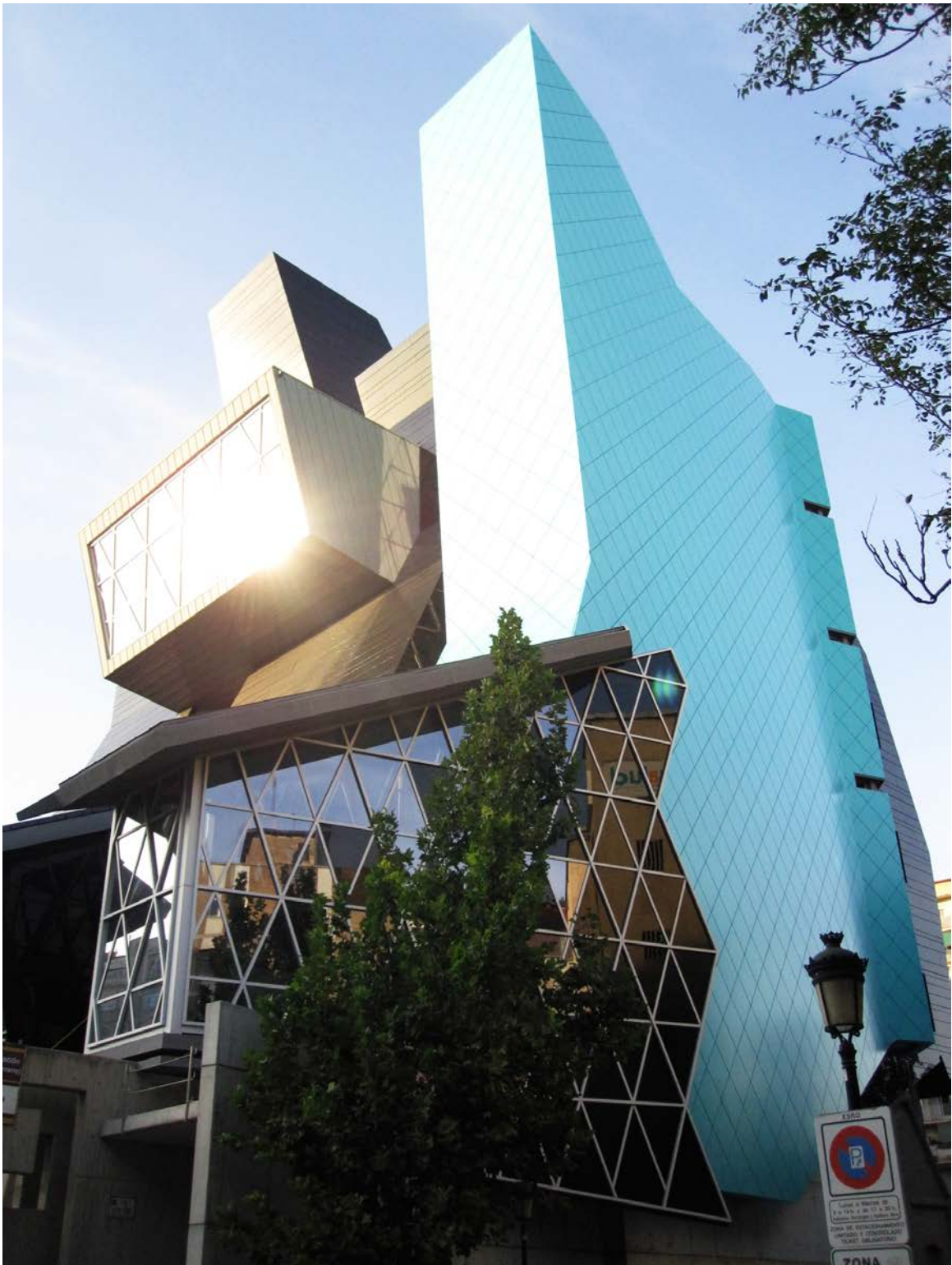
Figura 4.69 – Obras de ampliación. Septiembre de 2010
