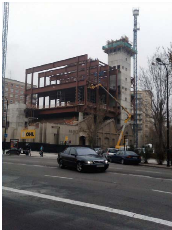
Figura 4.63 – Obras de ampliación. Diciembre de 2008
