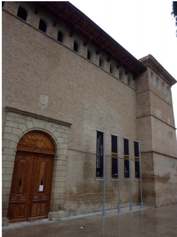
Figura 4.10 – Fachada actual del palacio
