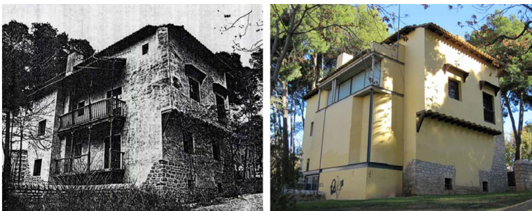
Figura 3.174 – Casa de Albarracín (Alejandro Allánegui), antes y después de la intervención para instalar la Sección de Etnología del Museo de Zaragoza (José Manuel Pérez Latorre)
