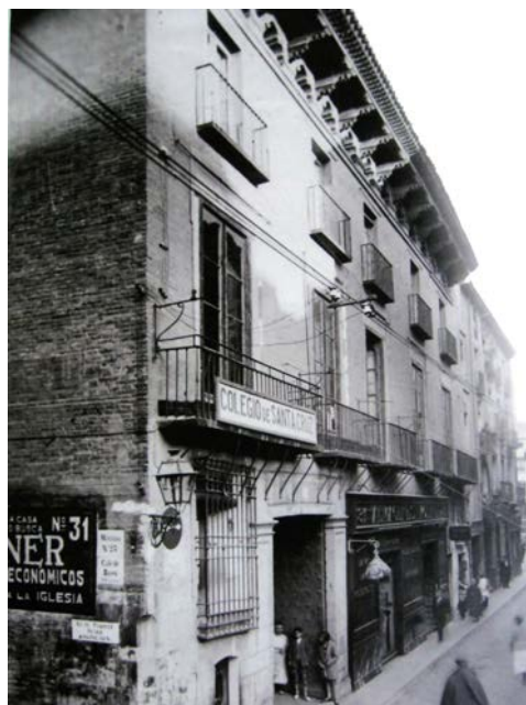
Fig. 4.20 – Estado de la fachada en 1930-1936 (Archivo Municipal de Zaragoza, Archivo fotográfico, signatura 02913)
