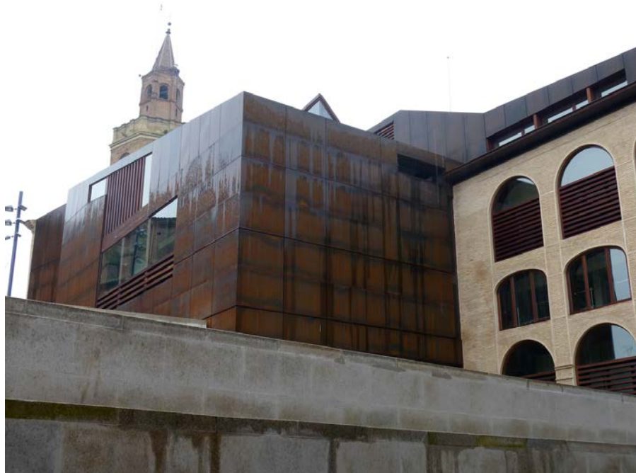
Figura 3.38 – Fachada lateral del palacio episcopal de Barbastro. Estado actual
