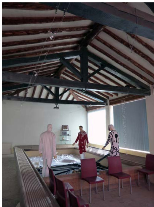
Figura 3.160 – Interior del Centro de Interpretación de la Contradanza de Cetina (Zaragoza)
