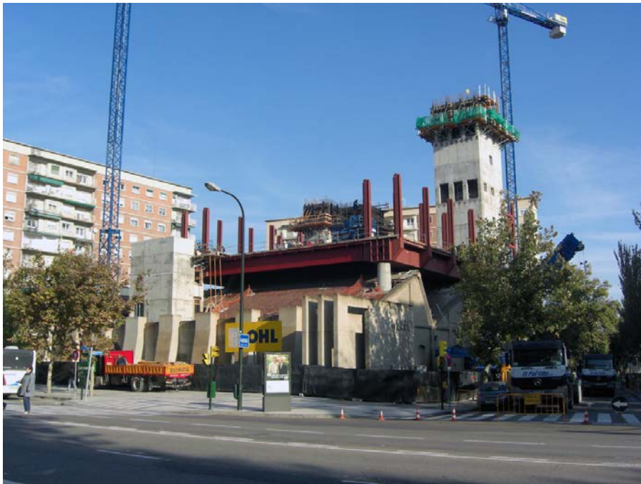
Figura 4.62 – Obras de ampliación. Noviembre de 2008
