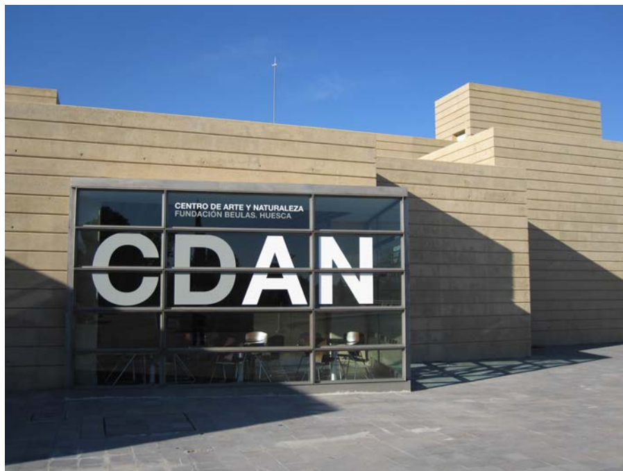
Figura 4.114 – Imagen de la fachada del edificio en la que se sitúa el acceso
