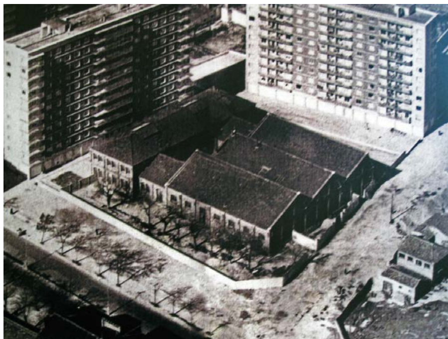
Figura 4.42 – Vista aérea de los talleres Pignatelli
