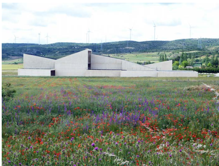
Figura 4.162 – Estado de las obras del nuevo Museo del Grabado de Fuentetodos en 2013
