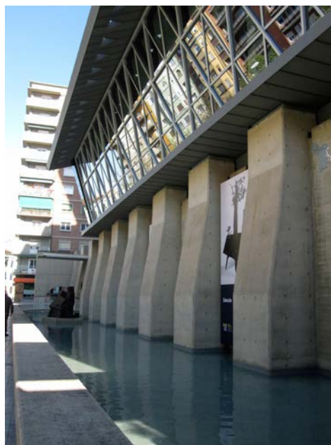
Fig. 4.72 – Fachada principal (detalle)
