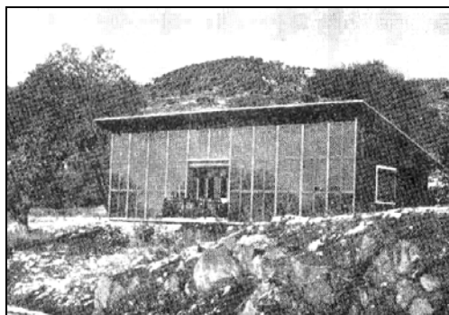
Figura 2.22. Casa con muro trombe, construida en los Pirineos Orientales. (Fuente: Yañez G., 1988).
