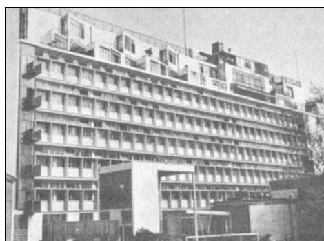
Figura 2.25. Fachada sur modificada del edificio de Le Corbusier 'La Cite de Refuge' (1933). (Fuente: Yañez G., 1988).
