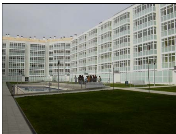
Figura 1.7. Bloque de 178 viviendas en manzana alargada orientado hacia el sur con patio interior en Residencial Parque Goya (Fase I). En la primera foto se muestra la fachada principal sur y el pequeño lateral este, mientras en la inferior se aprecia el patio interior con igual tratamiento de acristalamiento en la fachada sur y este que las que dan a las calles circundantes. (Fuente: GEE).
