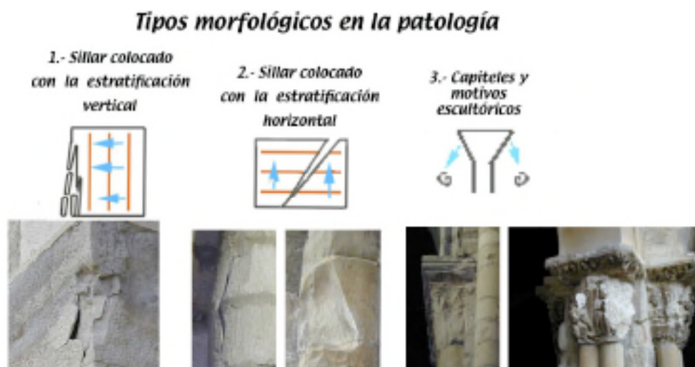
Figura VII-15: Expresión morfológica de la patología en función de la posición de la estratificación y del acabado de la pieza litológica.
