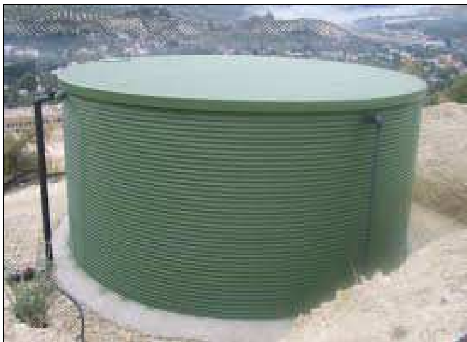
Imagen nº 32. Depósito de agua metálico de forma circular.
