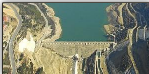
Fig. 2.- Foto en la que se observa la presa, su aliviadero de cuatro bocas y su desagüe (www.yesano.com, 2013).
