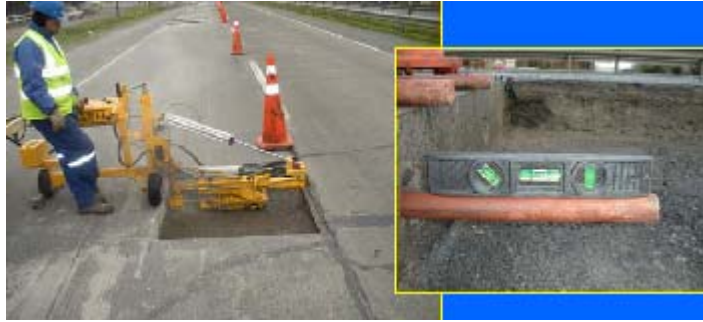
Ilustración 12. Instalación de barras de traspaso de carga.
