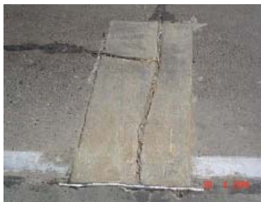
Ilustración 14. Reparación de espesor parcial B.
