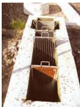
Figura 1. Rejas de desbaste, EDAR de las Tablas (Cádiz). Fuente: CENTA; Instituto Tecnológico de Canarias, (2006).
