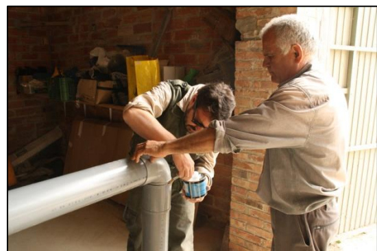
Figura 28. Pegando los fragmentos de PVC. Fuente: Oriol Barón Herrera.
