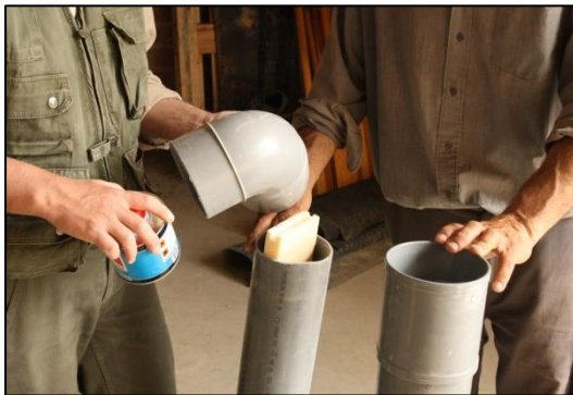
Figura 28. Pegando los fragmentos de PVC. Fuente: Oriol Barón Herrera.
