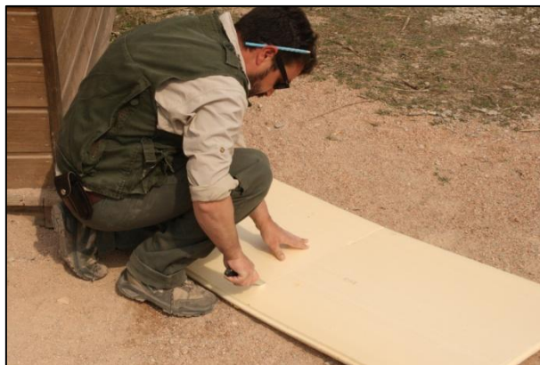
Figura 26. Cortando tiras de porexpan. Fuente: Oriol Barón Herrera.
