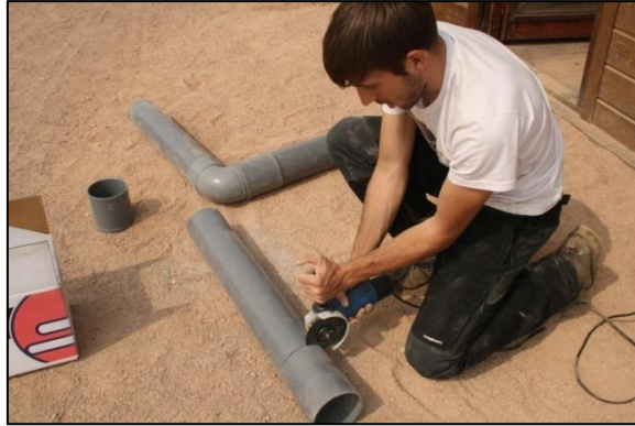
Figura 24. Cortando los tubos de PVC. Fuente: Oriol Barón Herrera.
