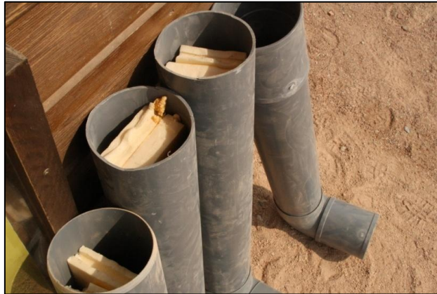
Figura 27. Introducción del porexpan en la estructura de PVC. Fuente: Oriol Barón Herrera.
