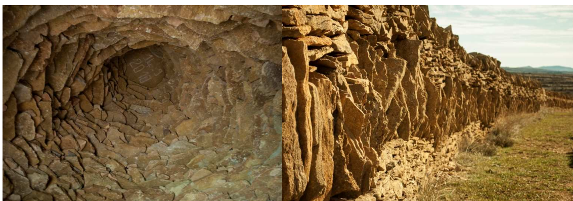
Interior de las casetas de pedra en seco
