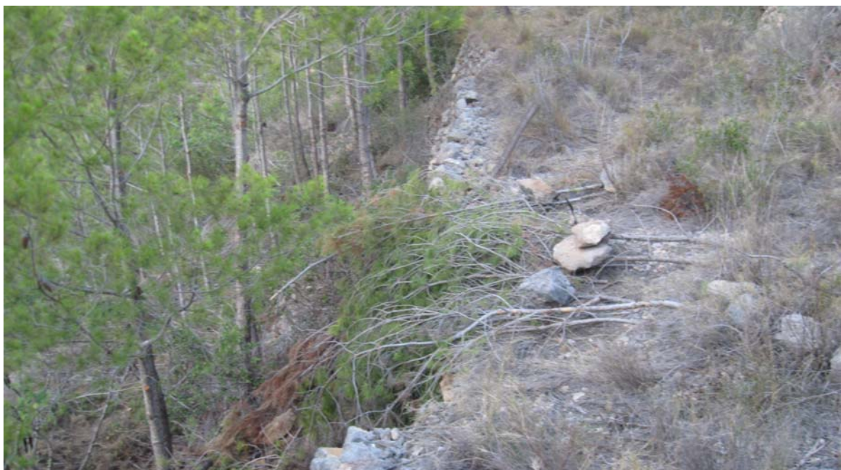
Imagen 2. Fagina adaptada al muro del talud.
