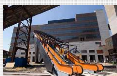
Instalación escalera exterior
