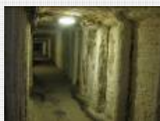
Sal impregnada en las entibaciones de madera, Pozo Danilowicz
