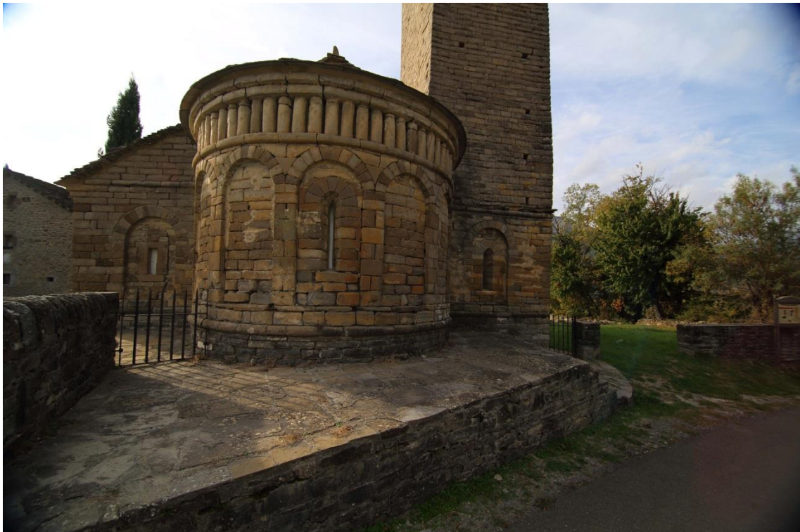
Detalle ábside semicircular con 7 arcadas ciegas y friso de baquetones. San Pedro de Lárrede. Fotografía propia
