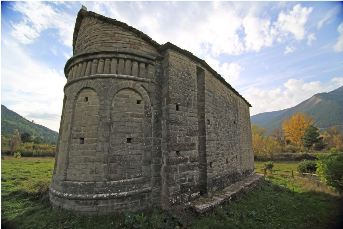
Vista exterior del ábside de San Juan de Busa. En ella vemos el muro levantado para servir de soporte de la techumbre tanto de la nave como del ábside.
