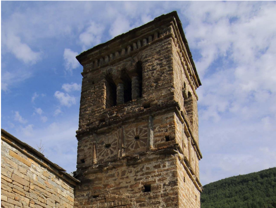
San Bartolomé de Gavín en la actualidad. Detalle de los rosetones decorativos de la torre, de las ventanas de tres arquillos de arco de herradura y de los baquetones debajo del tejado.
