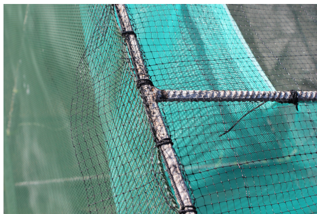
FIG.65 Ensamblaje de varas mediante soldadura.
