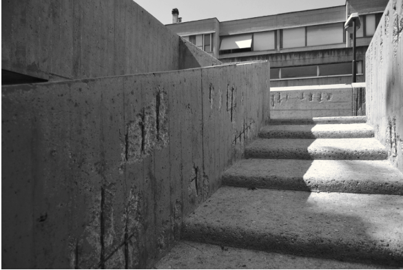
Muestras de desgaste del hormigón de la calle elevada
