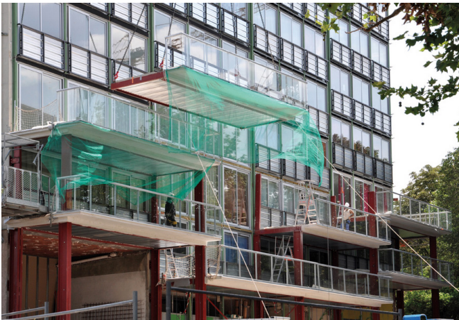
[5.35] Proceso de montaje desde la fachada resultante de la rehabilitación en 1990 hasta la diseñada por Lacaton y Vassal a partir de módulos prefabricados autónomos.
