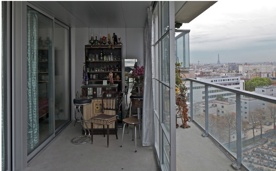
[5.41] [5.42] [5.43] [5.44] [5.45] Vistas del “jardín de invierno”, destacar el sistema de cerramientos ligeros así como las cortinas con función tanto térmica como lumínica.
