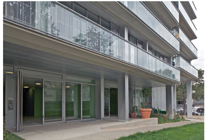
[5.35] Proceso de montaje desde la fachada resultante de la rehabilitación en 1990 hasta la diseñada por Lacaton y Vassal a partir de módulos prefabricados autónomos.
