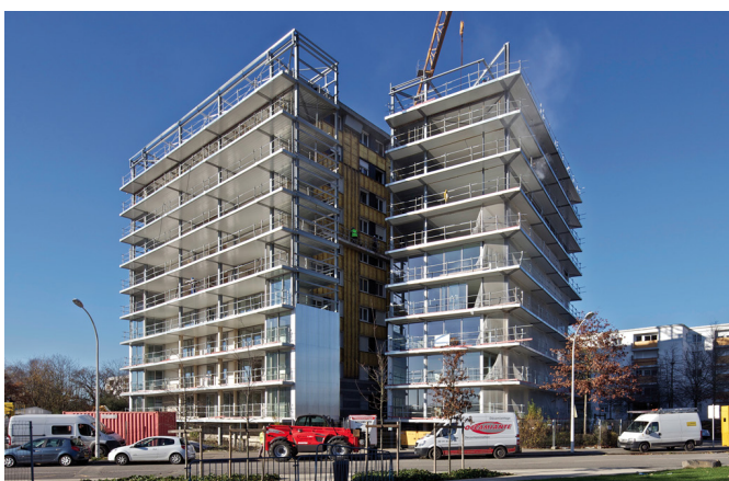
[5.67] Proceso de construcción del edificio a través de un sistema estructural metálico ligero basado en viga y pilares metálicos y forjados de chapa y hormigón.
