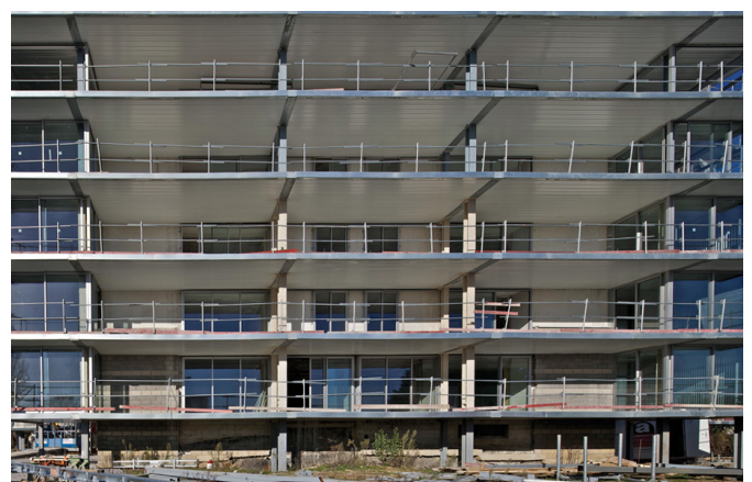
[5.67] Proceso de construcción del edificio a través de un sistema estructural metálico ligero basado en viga y pilares metálicos y forjados de chapa y hormigón.
