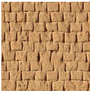
[Fig 4.8] Muro de fábrica de adobe. http://www.construtierra.org .
