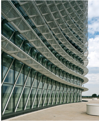
[Fig 2.1]. Pasarelas de mantenimiento. Torre del agua en Zaragoza. Enrique de Teresa Trilla. © Fernando Alda.
