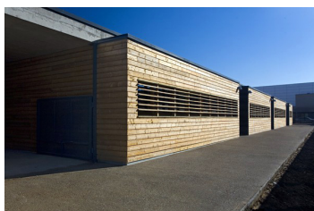
[Fig 4.13] Escuela Infantil Actur. Santiago Carroquino Arquitectos. En este caso, las tablas del encofrado de la envolvente de hormigón se reutilizan para generar los acabados en madera.
