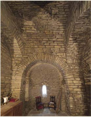
Figura 24_Muros y arcos, estructura torre y nave primigenia
