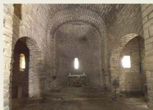
Figura 33_Ábside, paso de bóveda de cañón a bóveda de horno
